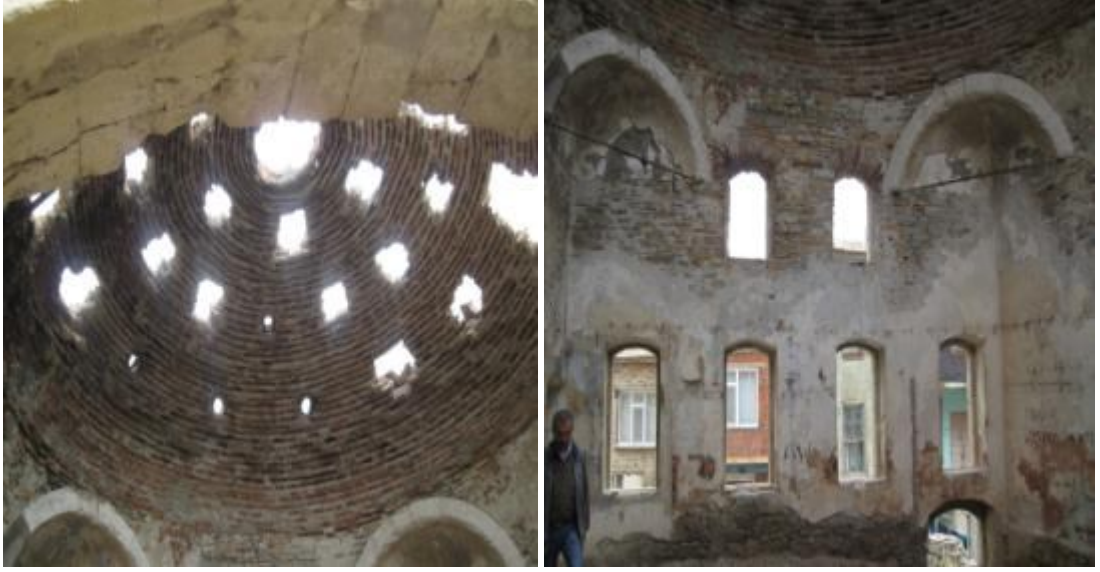
Şekil 4.20. Yukarı hamam kubbe ve taşıyıcı sistemi
