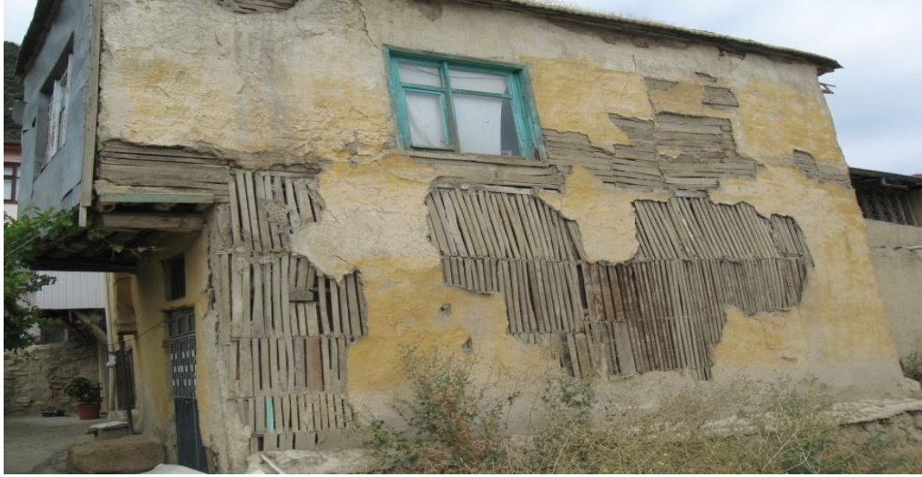
Şekil 4.37. Bağdadi yapım tekniğiyle yapılmış Akşehir evi
