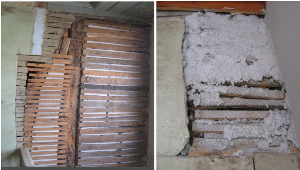
Şekil 4.38. Akşehir Aslımlar evi bağdadi yapım uygulaması
