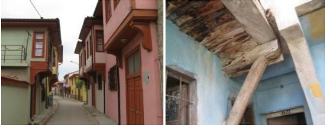
Şekil 4.59. Çıkma, cumbaları ve payanda görünümü
