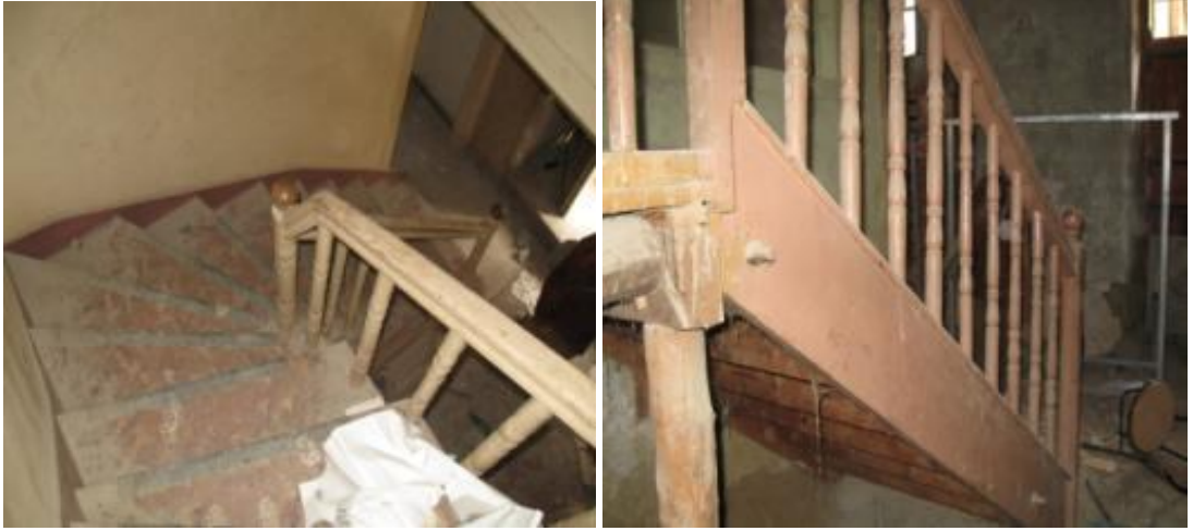
Şekil 4.54. İç merdiven görüntüsü
