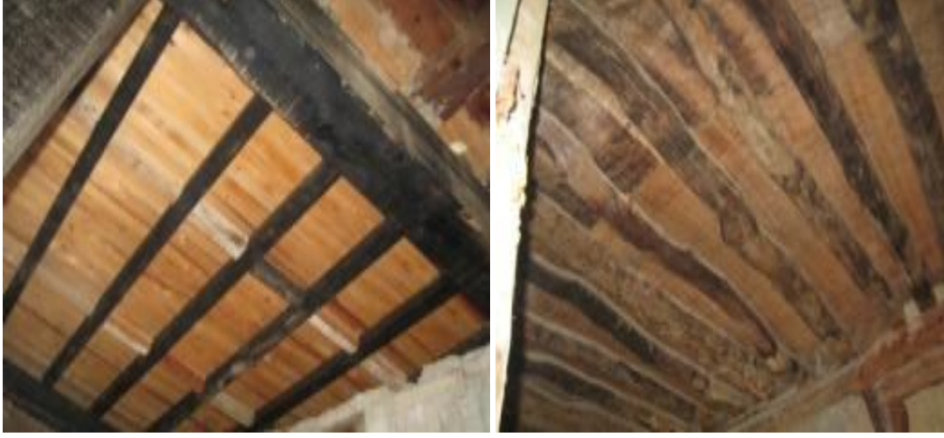
Şekil 4.41. Çatı elemanları ve ahşap kirişler
