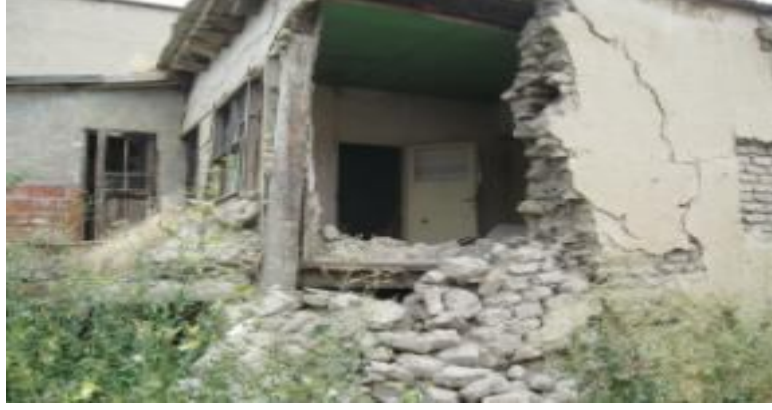
Şekil 4.34. Akşehir evlerin ahşap ve kerpiçin kullanımı
