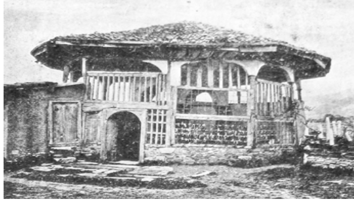
Şekil 4.16. Nasreddin Hoca türbesinin restorasyonlar öncesi görünüşü (Anonim, 2011c)
