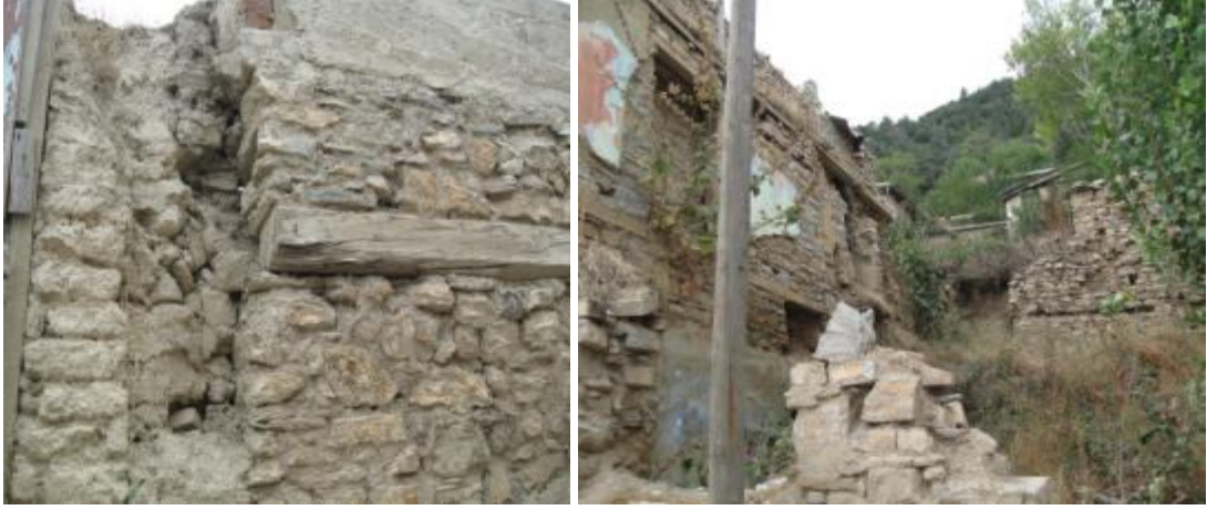
Şekil 4.33. Yığma taş duvar örneği
