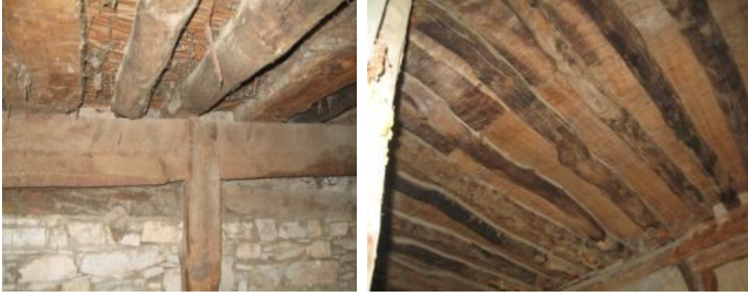
Şekil 4.55. Dikme ve ahşap kirişler
