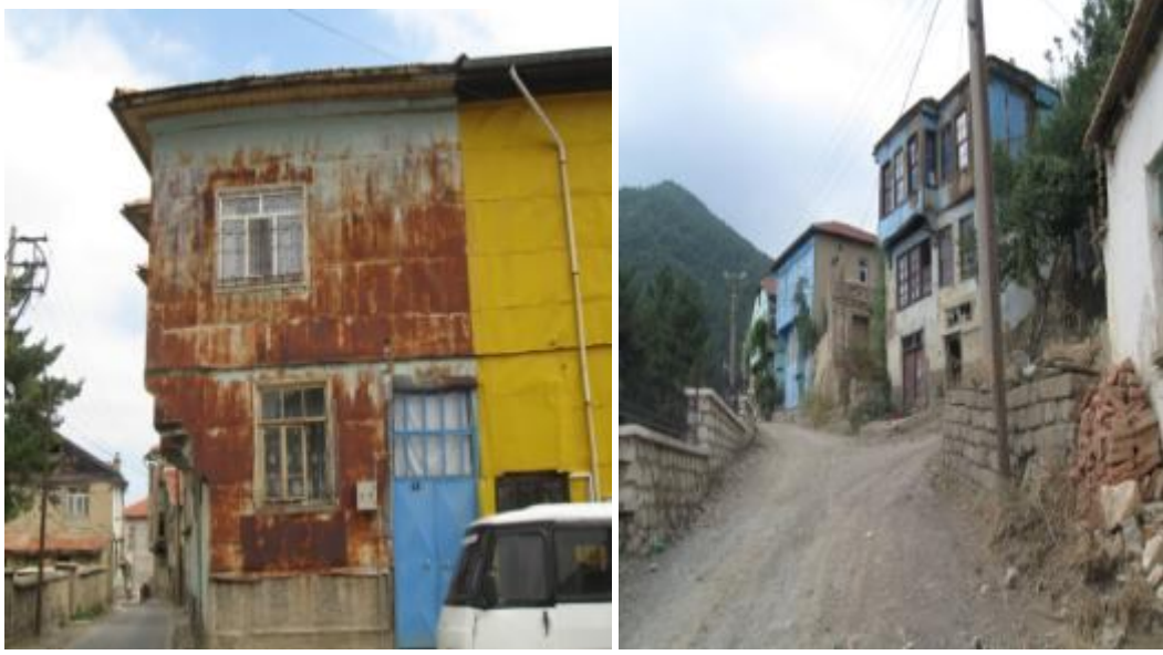
Şekil 4.42. Geleneksel Akşehir evlerinde metal kaplama kullanımı
