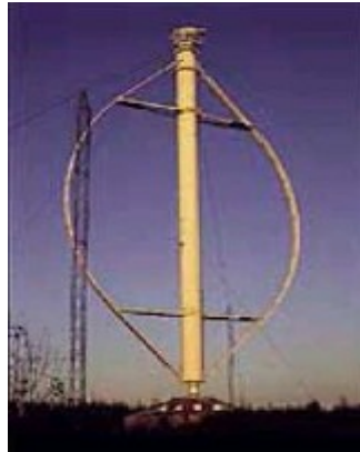
Şekil 1.1 : Darius tipi rüzgâr türbini [2]
