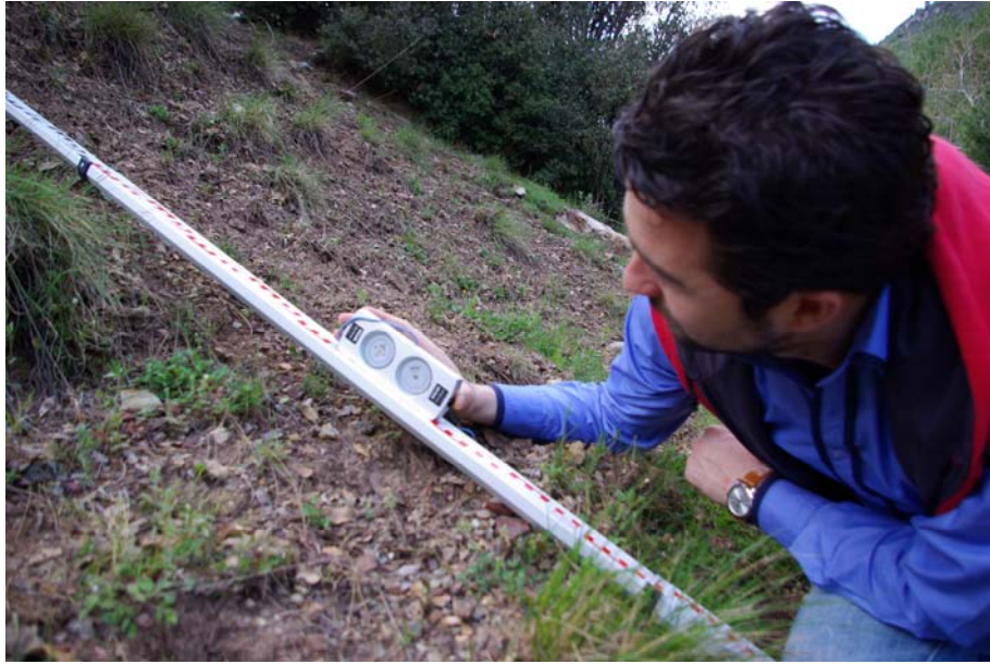
Şekil 3.18. Durma noktalarında kazı şevi eğiminin ölçülmesi
