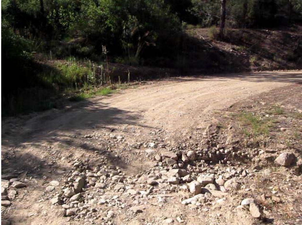
Şekil 3.23. Yol boyunca kesilen dere sayısı
