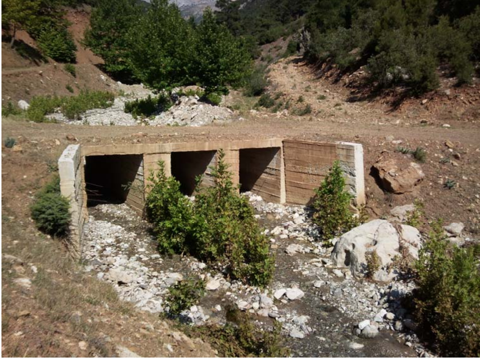
Şekil 3.25. Yol boyunca sanat yapılarının ölçülmesi
