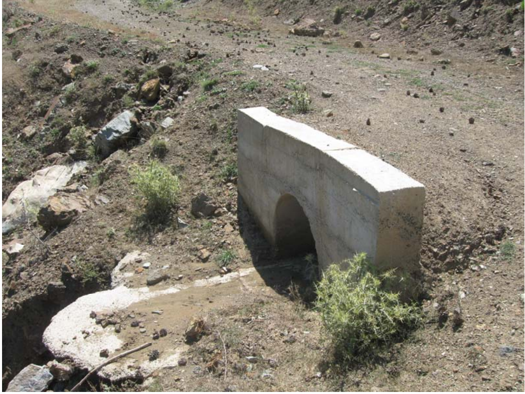
Şekil 3.26. Yol boyunca farklı tiplerdeki sanat yapılarının ölçülmesi
