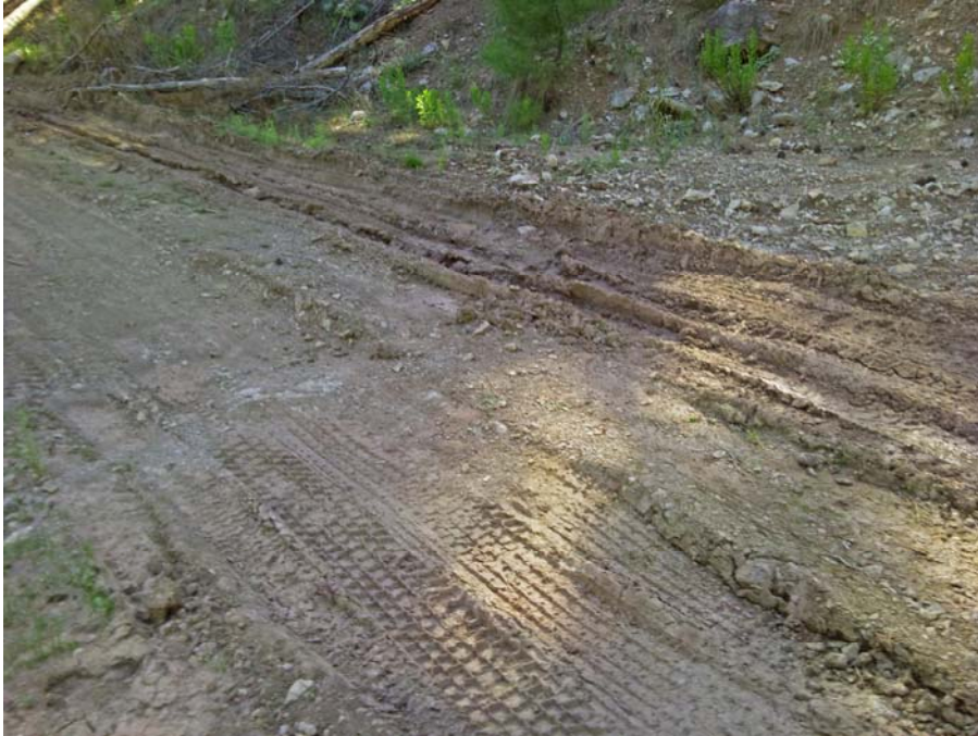
Şekil 3.21. Durma noktalarında teker izlerinin incelenmesi
