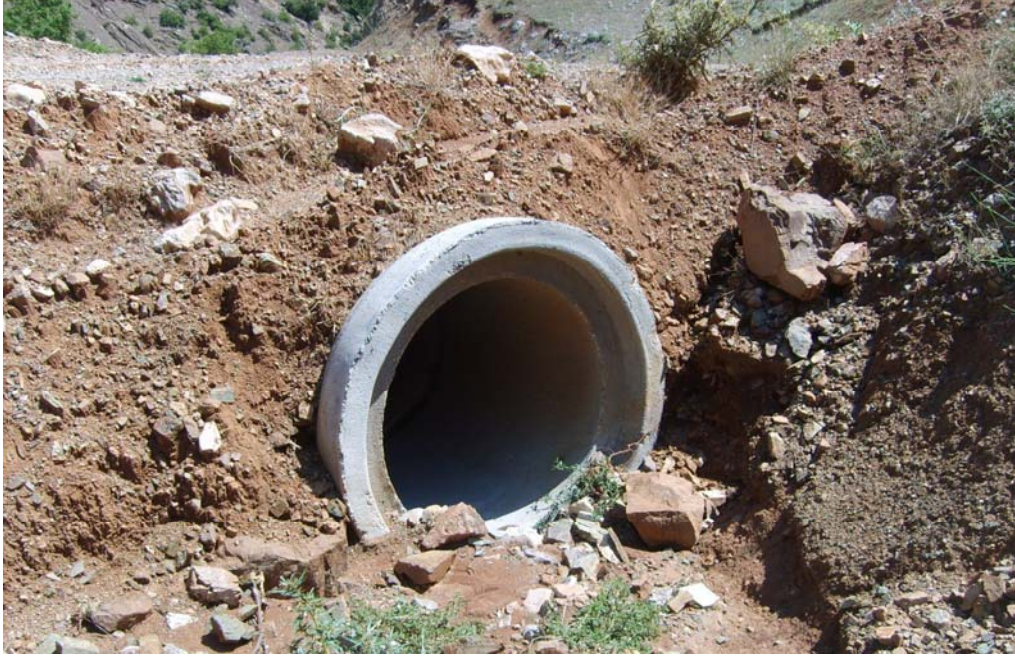
Şekil 3.27. Yol boyunca farklı tiplerdeki sanat yapılarının ölçülmesi
