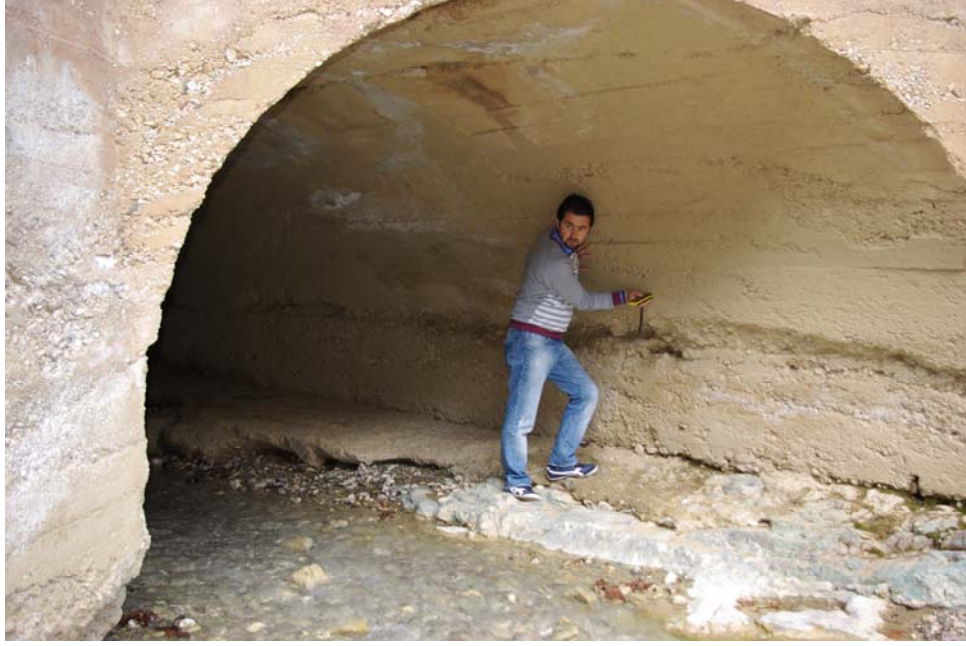
Şekil 3.28. Yol boyunca sanat yapılarının özelliklerinin ölçülmesi
