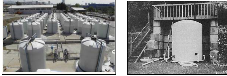
Şekil 2.15. Sıvı kimyasal depoları
