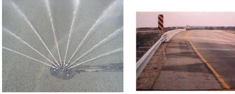
Şekil 2.21. Yola ve yol kenarına yerleştirilmiş püskürtme sistemleri
