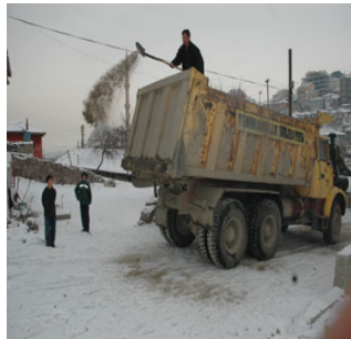
Şekil 3.8. Karayollarında buzlanma ile mücadelede tuz kullanımı
