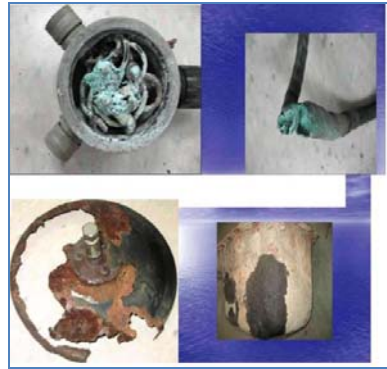
Şekil 2.17. Tuzun neden olduğu bazı malzemelere ait korozyon örnekleri
