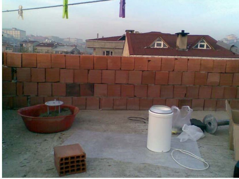
Şekil 7.5: Yağış Ölçer'in ayaklığı için çimento harcı yapımı
