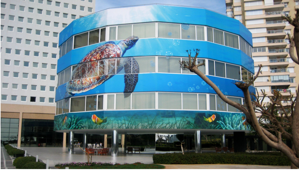
Resim 3.1. 360° Döner Revolving Loft Binası
