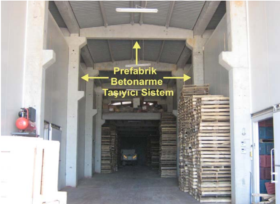
Şekil 4.2. Taşıyıcı sistem olarak prefabrik betonarmenin kullanıldığı depodan bir görünüm (Gelendost)
