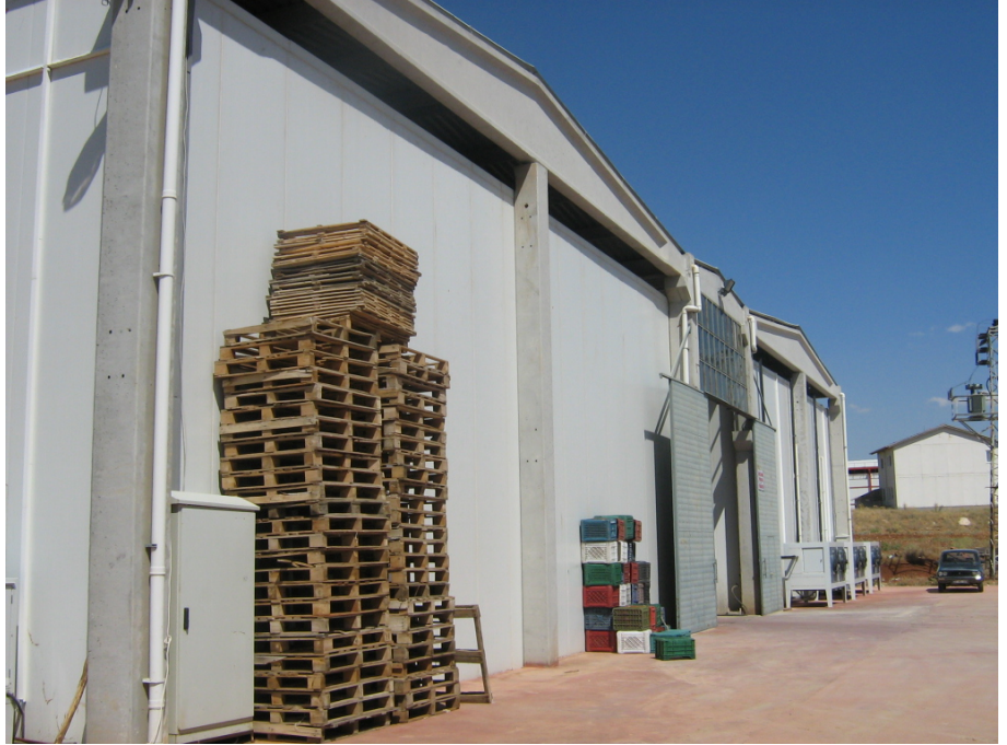
Şekil 4.5. Duvar yapı malzemesi olarak PU panelin kullanıldığı depodan bir görünüm (Gelendost)
