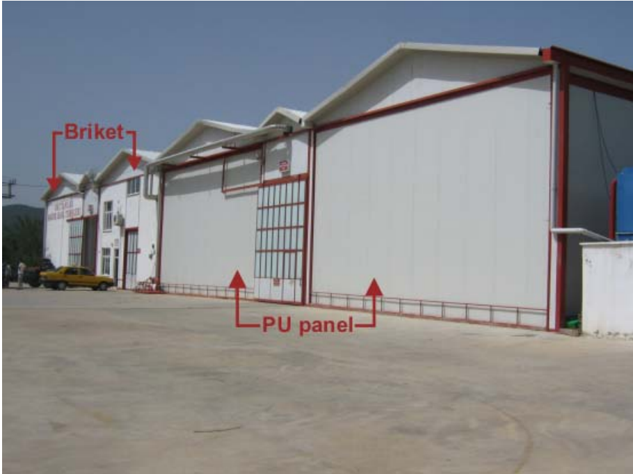
Şekil 4.7. Duvar yapı malzemesi olarak briket ve PU panelin birlikte kullanıldığı depodan bir görünüm (Eğirdir)
