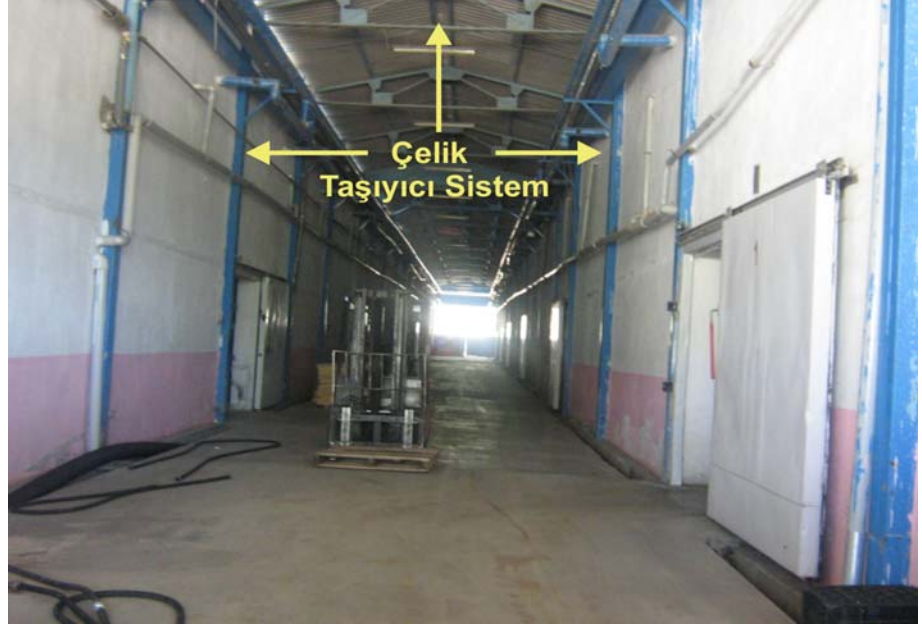
Şekil 4.3. Taşıyıcı sistem olarak çeliğin kullanıldığı depodan bir görünüm (Eğirdir)
