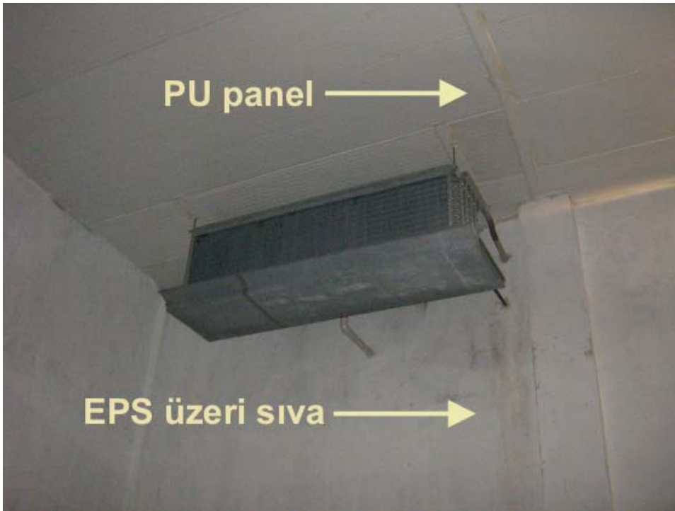
Şekil 4.11. EPS ve PU panelin birlikte kullanıldığı depodan bir görünüm (Gelendost)
