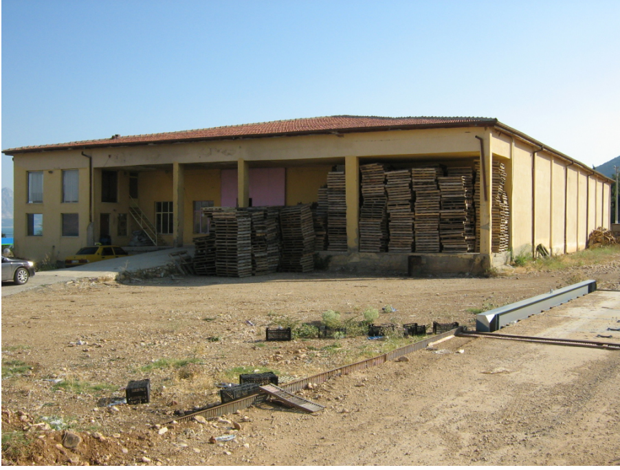
Şekil 4.6. Duvar yapı malzemesi olarak tuğlanın kullanıldığı depodan bir görünüm (Eğirdir)
