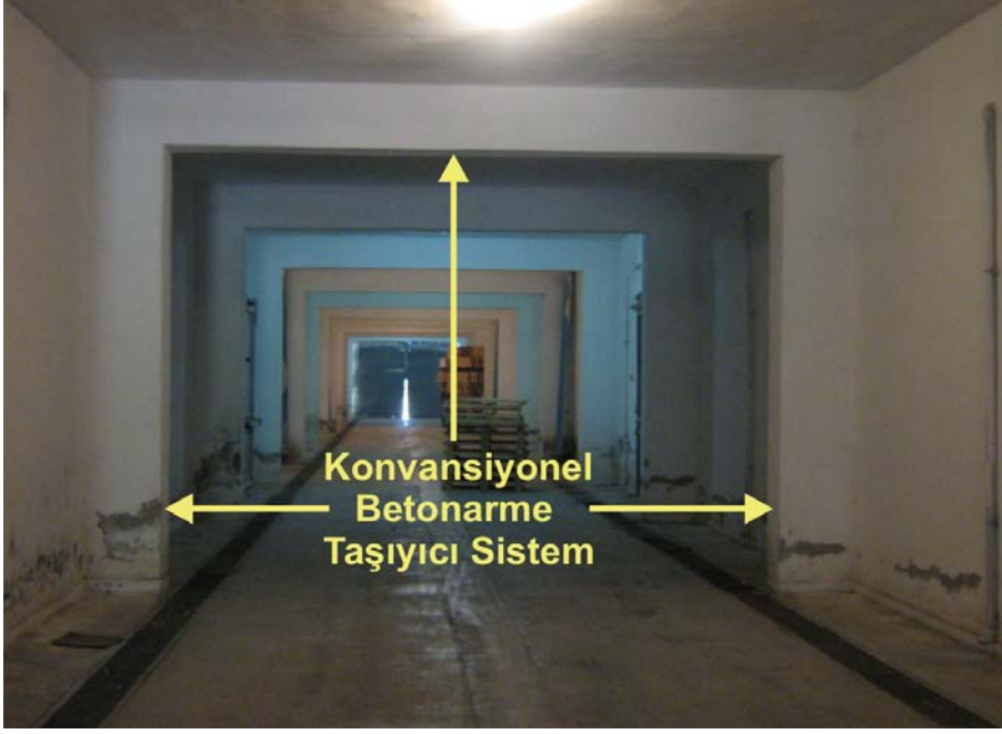
Şekil 4.1. Taşıyıcı sistem olarak konvansiyonel betonarmenin kullanıldığı depodan bir görünüm (Gelendost)
