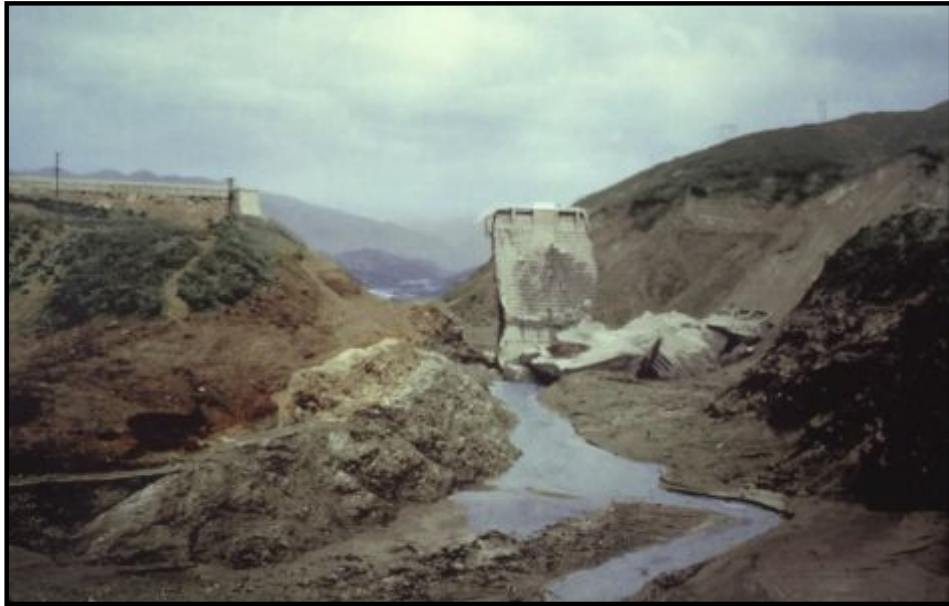
Şekil 1.16. San Francis barajının yıkıldıktan sonraki hali ( http://web.mst.edu )
