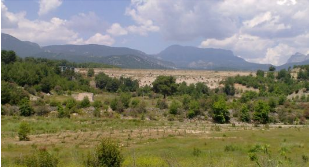
Şekil 4.5 Baraj gövdesi genel görünümü (mansap tarafı)
