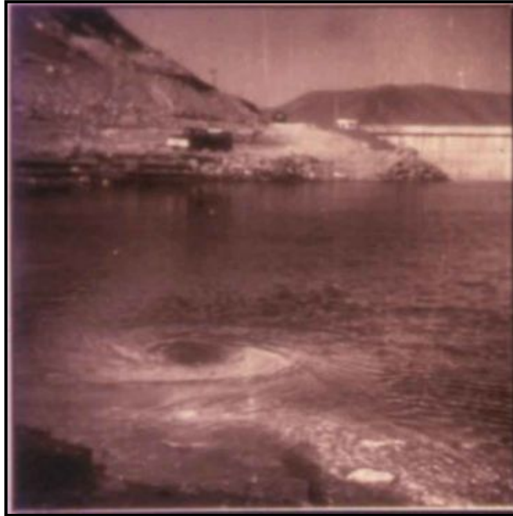
Şekil 1.23 Keban Barajı sol yamaç Petek Mağarası'ndan su kaçakları (Ertunç, 2003)
