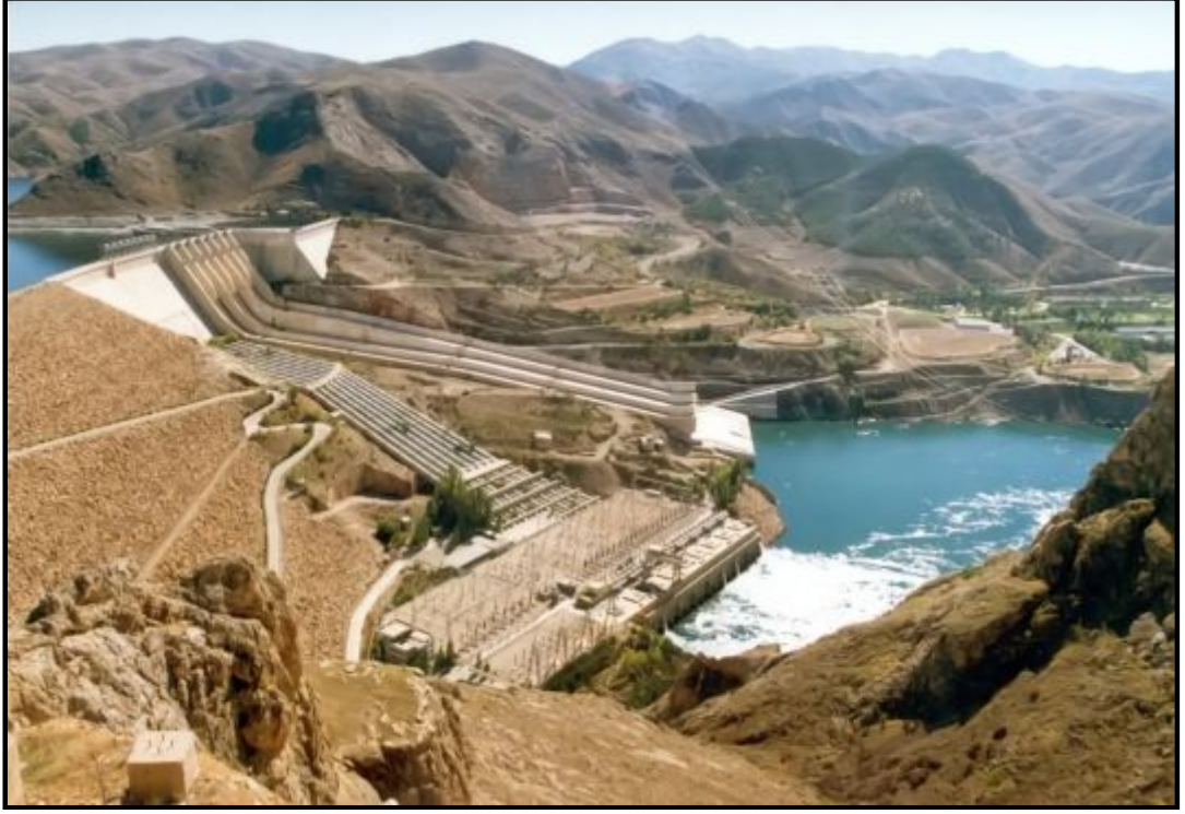
Şekil 1.22 Keban Barajı genel görünümü ( http://img234.yukle.tc/ )
