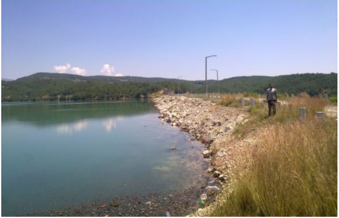
řekil 4.6 Baraj gövdesi görünümü (membra tarafı)
