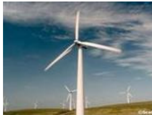
Resim 2.7 Elektrik üreten yatay eksenli 3 kanatlı bir rüzgar türbini
