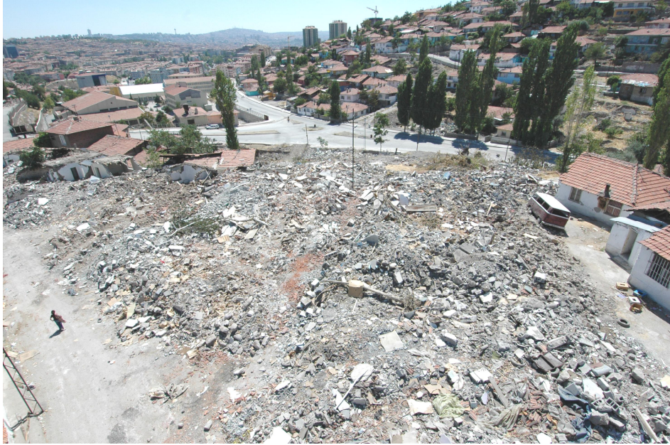
Resim 3: Gecekondu Yıkım Çalışmalarından Örnekler
