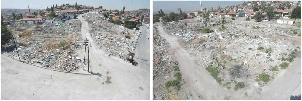
Resim 2: Gecekondu Yıkım Çalışmalarından Örnekler
