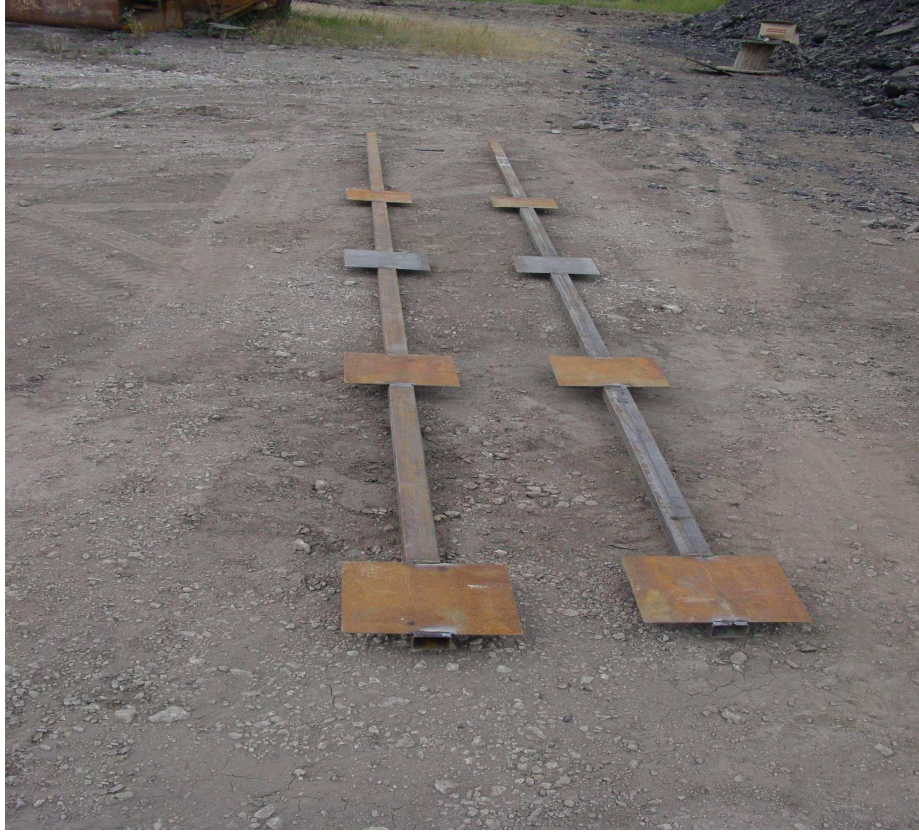
Şekil 4.8. Yığın üstüne konulan profiller
