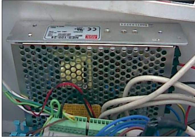
Şekil 3.12. 24 V DC güç kaynağı
