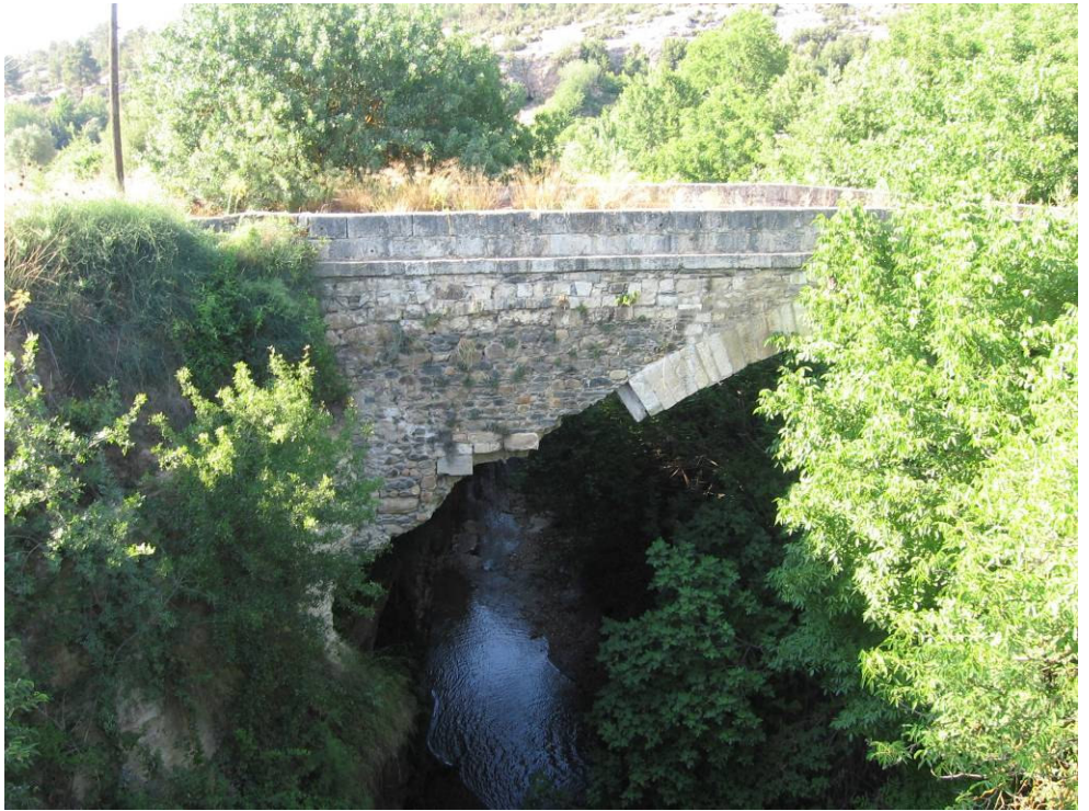
Şekil 1.5. Dandalas Köprüsü Karacasu Aydın
