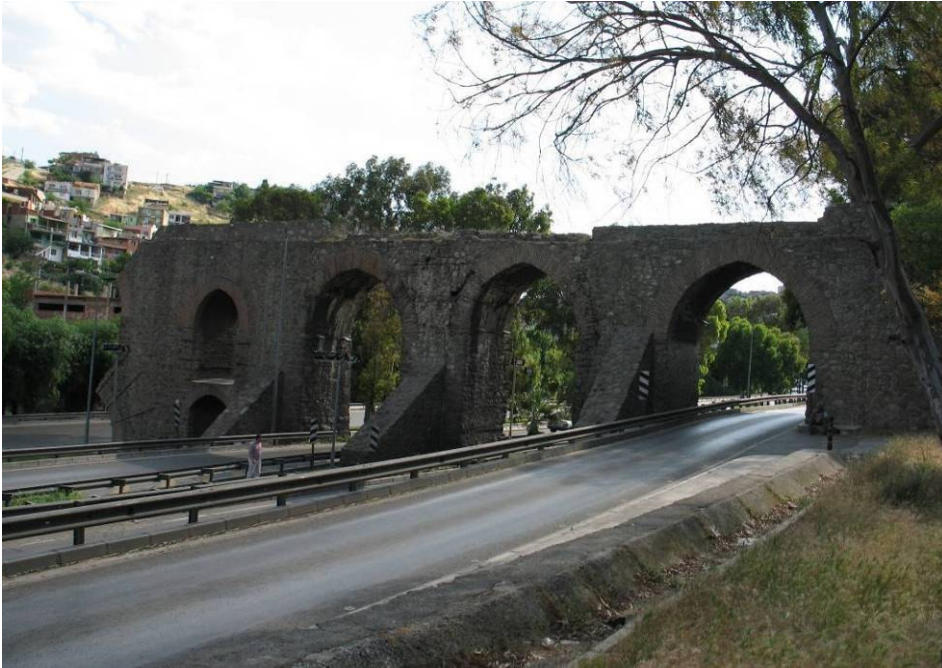
Şekil 5.2. Vezir Su Kemerî Doğu Cephesi
