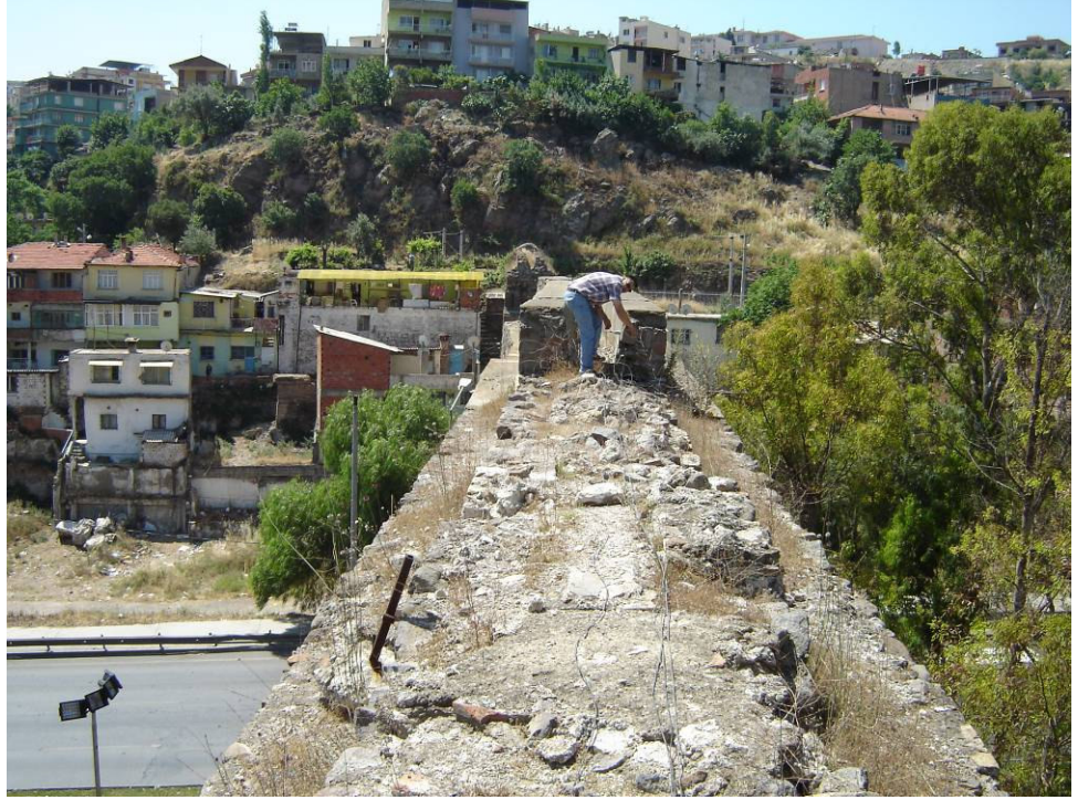
Şekil 5.68. Su kemerine ivmeölçerlerin yerleştirilmesi
