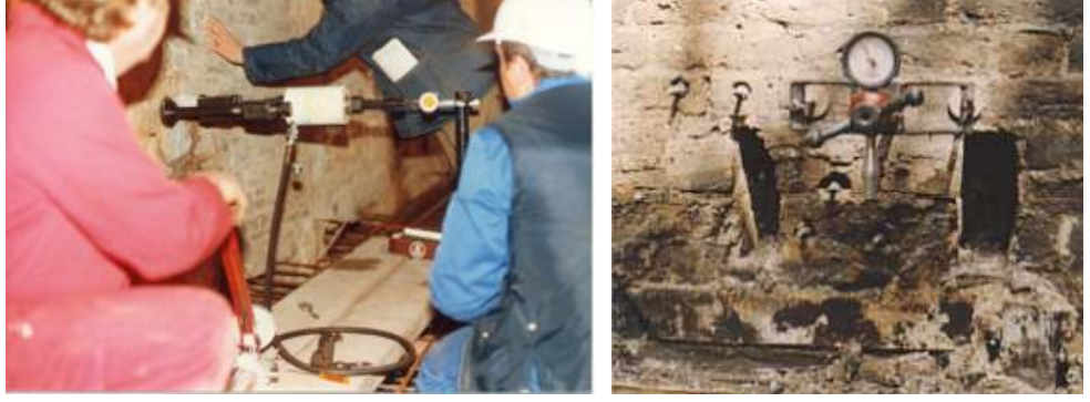
Şekil 4.5. Mevcut yığma duvarda çekip çıkarma testi (Cintec, 2010)
