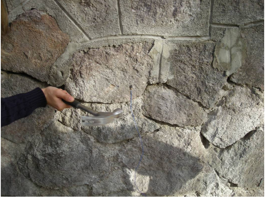
Şekil 5.89. Darbe-eko testinin köprü ayaklarında uygulanması
