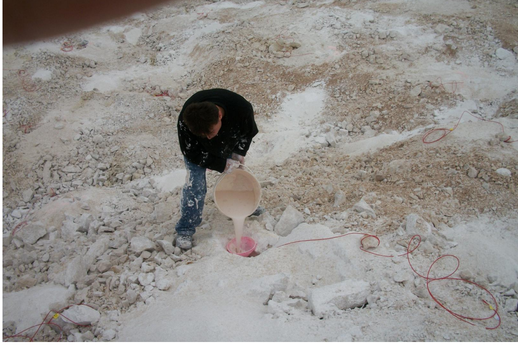
Şekil 3.12. Alçı bulamacı ile deliklerin sıkılanması
