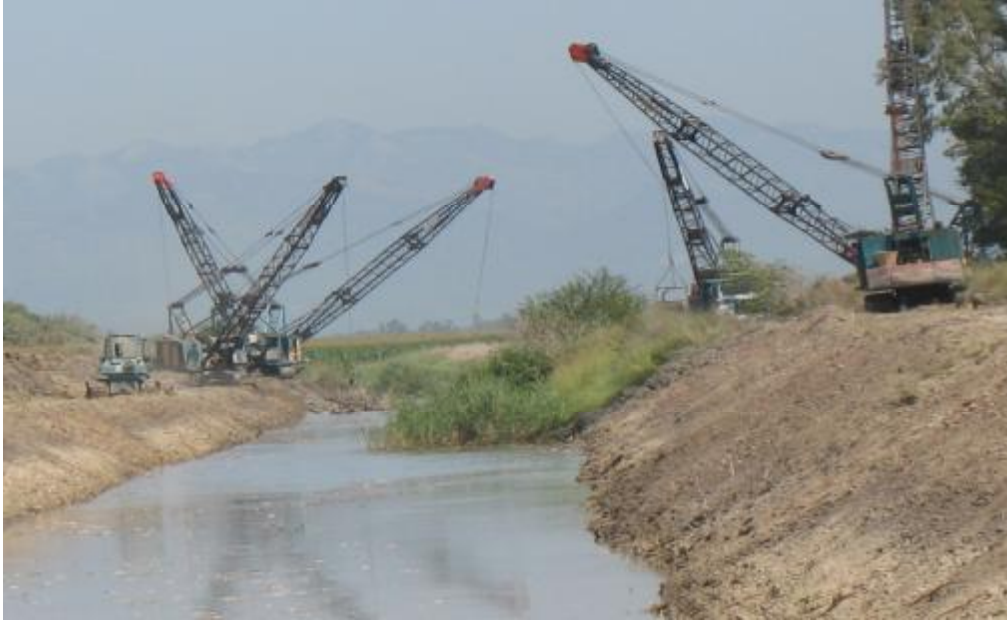
Fotoğraf 4.2. Kadirli drenaj Kanalı Temizliđi
