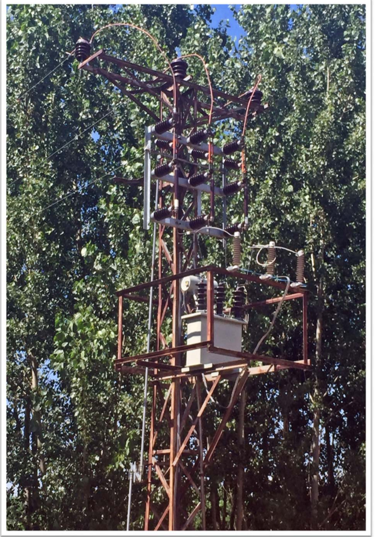
Şekil 4.18. Saha pilot uygulaması parafudr yeni irtibatları
