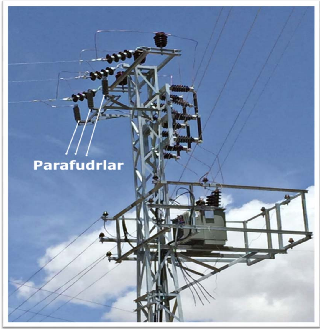
Şekil 3.17. Direk tipi trafo tesisinde OG parafudr bağlantısı
