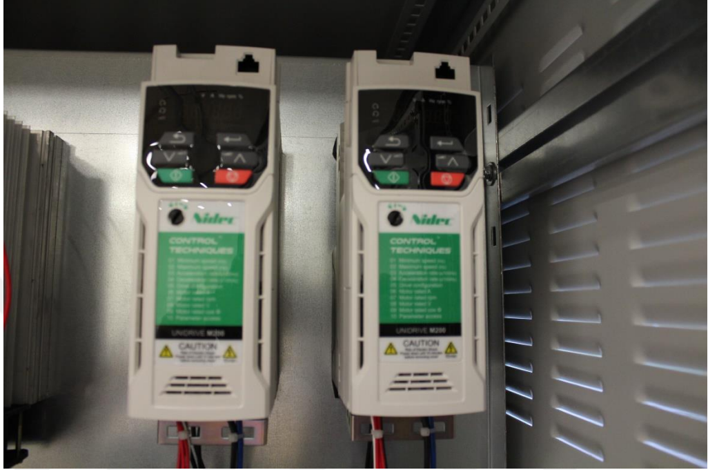
Şekil 3.9 Frekans Kıyıcılar (motor sürücüler)
