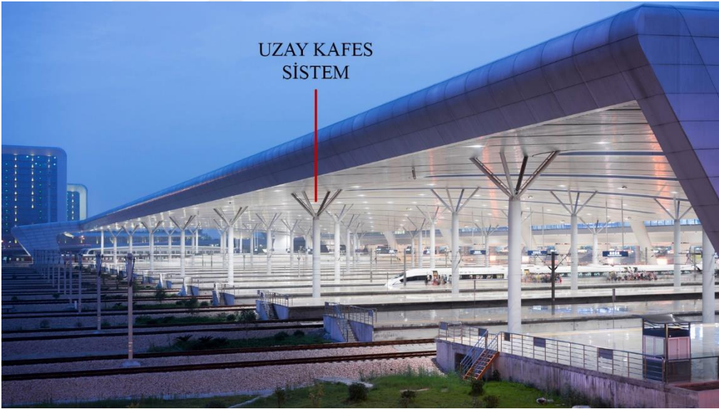
Resim 3.28. Hangzhou Güney Demiryolu İstasyonu strüktürü-uzay kafes sistemi [23]
