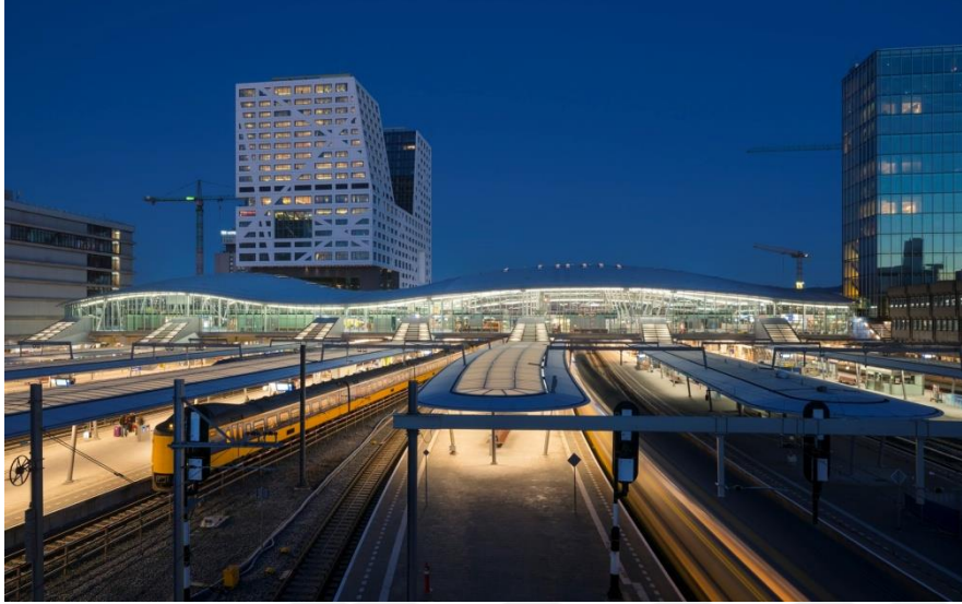
Resim 3.12. Utrecht Merkez İstasyonu görünüşü [17]
