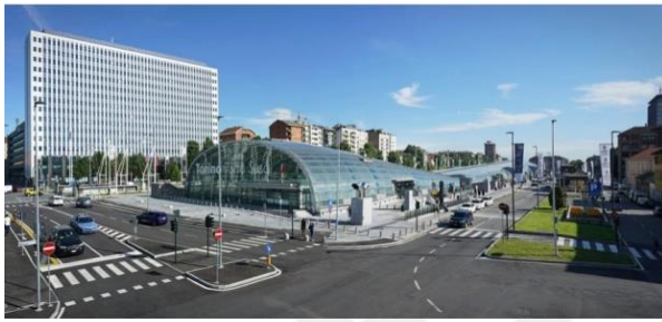
Resim 2.2. Porta Susa Tgv İstasyonu görünüşü [12]
