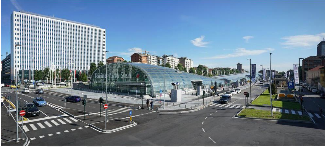
Resim 3.1. Porta Susa TGV İstasyonu görünüşü [12]
