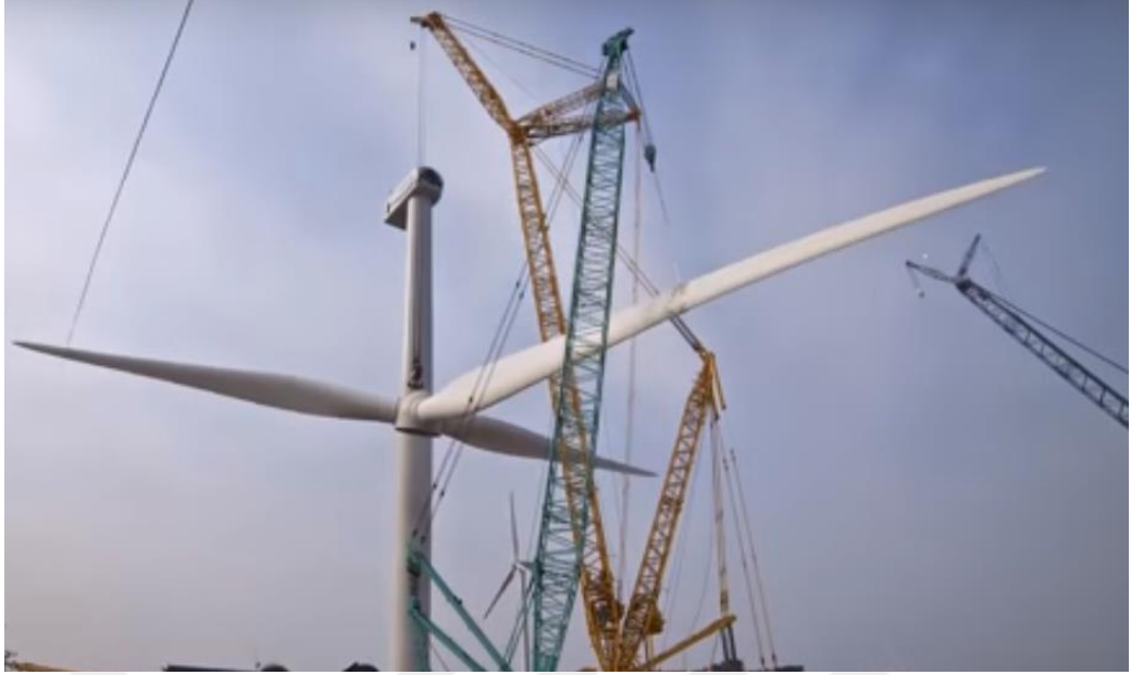
Şekil 1.9. Rüzgar Türbin kanatlarının kule'ye kaldırılması
