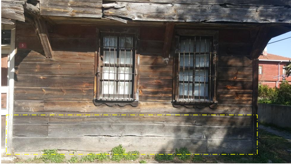
Şekil 4.64 50 Envanter cephe kaplaması (Derya Arkan, kişisel arşiv, 2020)
