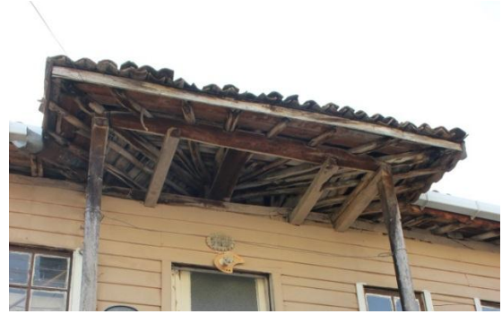
Şekil 4.54 55 Envanter saçak altı kaplamasız çatı (Derya Arkan, kişisel arşiv, 2020)
