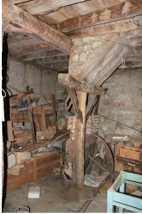
Şekil 4.43 Ocak taşıyıcı sistemi (Derya Arkan, kişisel arşiv, 2019)
