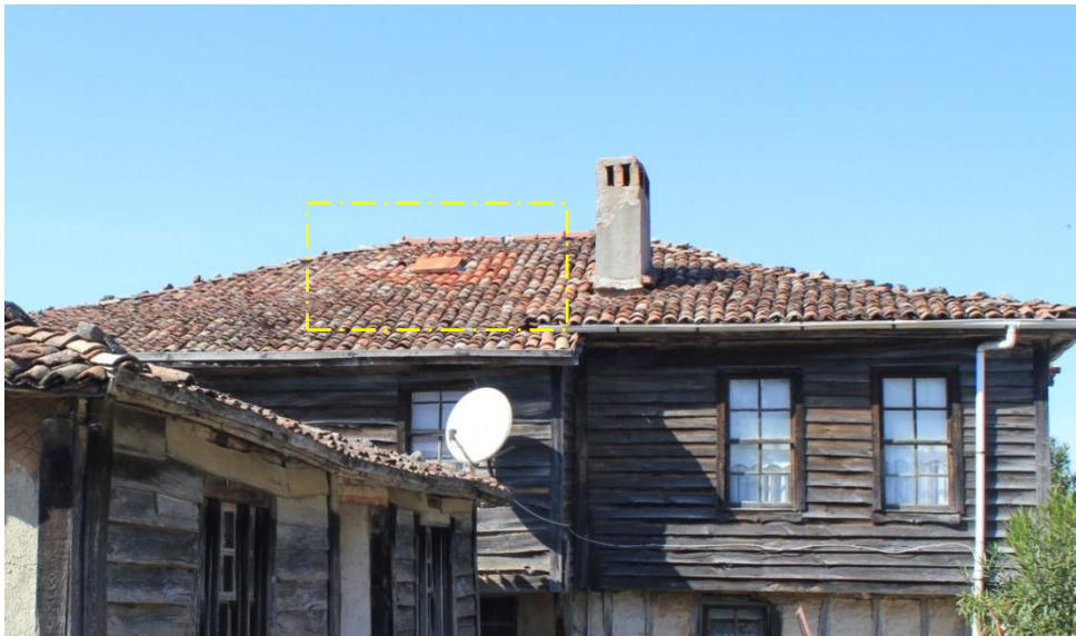
Şekil 4.118 Örnek çatı kaplaması (Derya Arkan, kişisel arşiv, 2020)
