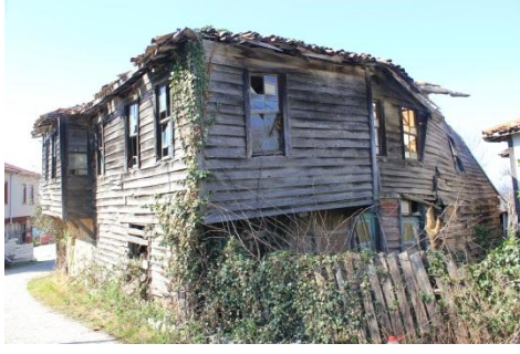
Şekil 4.98 17 Envanter kullanım dışı yapı (Derya Arkan, kişisel arşiv, 2020)
