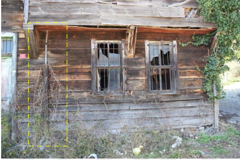
Şekil 4.117 14 Envanter cephe kaplaması (Derya Arkan, kişisel arşiv, 2020)
