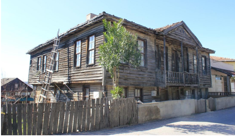
Şekil 4.52 27 Envanter cephe, çatı bakım merdiveni, çatı (Derya Arkan, kişisel arşiv, 2020)
