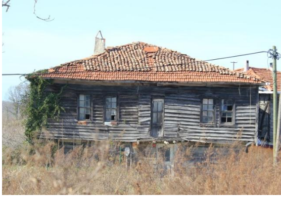
Şekil 4.104 Çatısı onarım görmüş yapı (Derya Arkan, kişisel arşiv, 2020)
