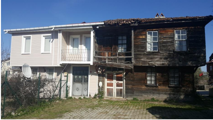
Şekil 4.95 Muhdes eklentileri sebebi ile niteliğini kaybetmiş yapı (Derya Arkan, kişisel arşiv, 2020)
