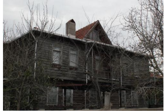
Şekil 4.105 Çatı arasına muhdes birim eklenmiş yapı (Derya Arkan, kişisel arşiv, 2019)
