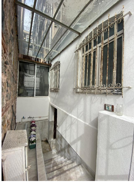
Şekil 5. 67: Eseyan Yalısı batı cephesi kısmi görünümü (Özgül, 2019)
