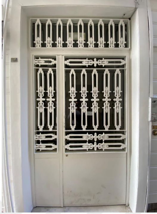
Şekil 5. 46: Sandalciyan Yalısı yan (doğu) cephe giriş kapısı
