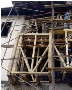
Şekil 241. Hacımemişler Konağı Taşıyıcıların Yenilenmesi [246]
