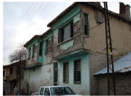
Şekil 148. Ahşap Ev-Odunpazarı Bağdadi sıva [184]
