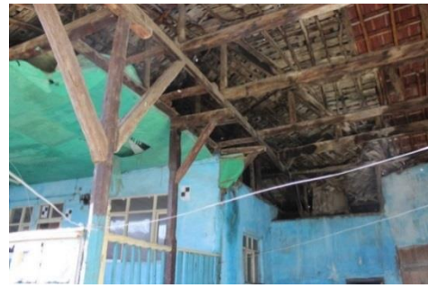
Şekil 376. Ahşap Dikmeler ve Payandalar [265, 272]
