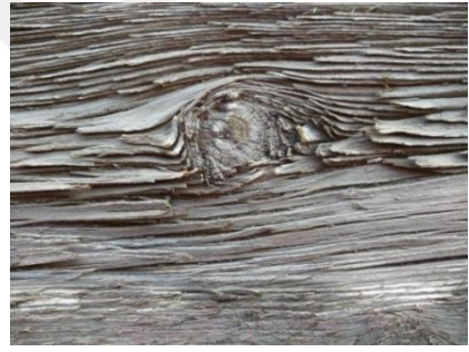
Şekil 522. Doğrama Aşınması [168]
