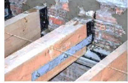
Şekil 255. Kiriş Bağlantısı [250]
