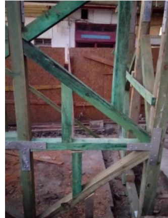
Şekil 534. Taşıyıcı Eleman Birleşimleri [265]
