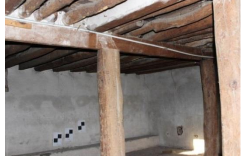
Şekil 411. Zemin Kat Ahşap Kirişler [265, 272]
