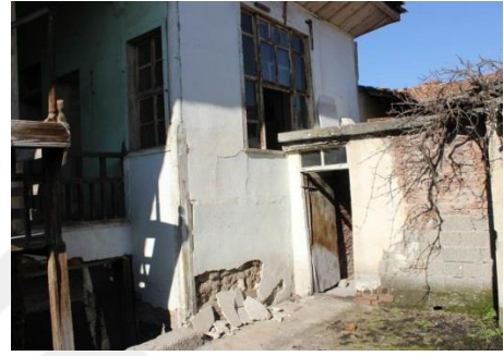
Şekil 407. Kale İçi 3. Ev Duvar [265, 272]
