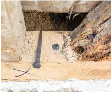
Şekil 249. Taban Tahtasının Taş Duvara Monte Edilmesi [249]
