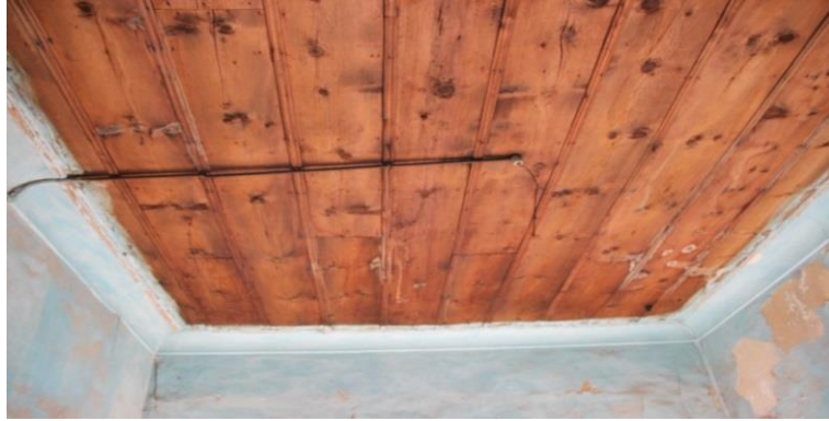
Şekil 300. Çıtalı Ahşap Kaplama Tavan [265, 271]
