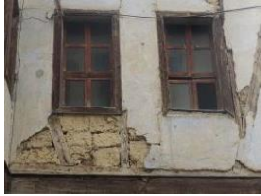
Şekil 138. Ahşap dolgu-Safranbolu [170] Şekil 139. Kerpiç dolgu-Safranbolu [170]
