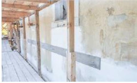
Şekil 254. Duvarın Hareketini Engelleyen Levha [250]
