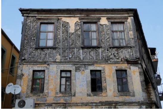
Şekil 134. Muskalı Dolma Tekniği İle İnşa Edilmiş Bir Ev [171]
