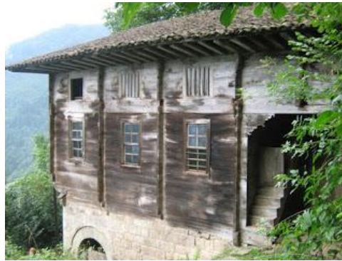
Şekil 129. Blok ahşap dolma sistem [172]
