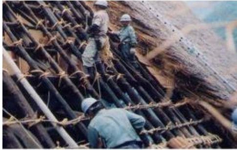
Şekil 210. Geleneksel Evde Çatı Bakımı [232]
