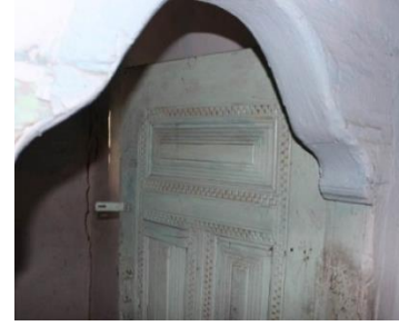
Şekil 399. Özgün Ahşap Kapı [265, 272]
