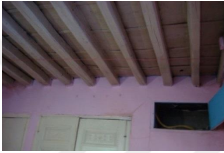
Şekil 373. Birinci Kat Ahşap Ters Tavan [265, 272]
