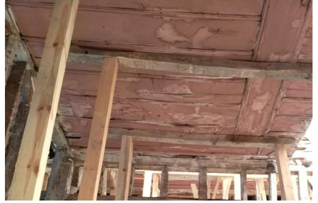
Şekil 514. Nemden Kaynaklanan Bozulmalar [168]
