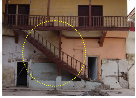
Şekil 514. Nemden Kaynaklanan Bozulmalar [168]
