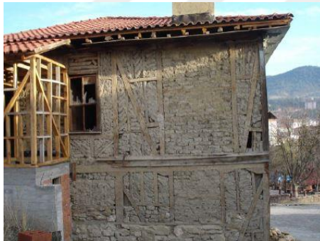
Şekil 159. Taşıyıcı Sistem-Çakırlar Konağı [195]
