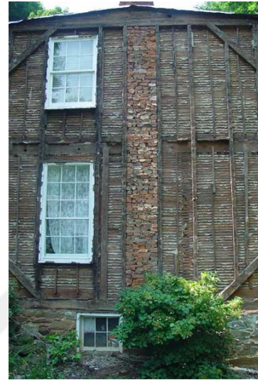
Şekil 104. Balon Çerçeve Sistem [141]
