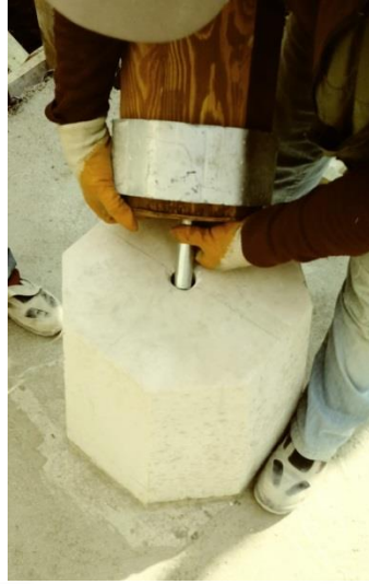
Şekil 535. Güçlendirilmiş Dikmelerin Yerleştirilmesi [265]
