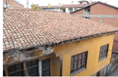
Şekil 337. Alaturka Kiremit Kaplama [265, 271]
