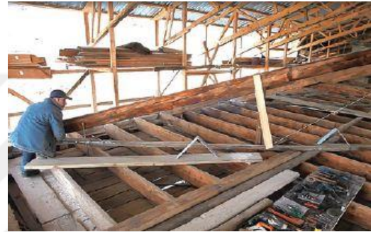
Şekil 264. Gergi İşlemi Sonrası Aşıklar [251]
