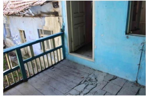
Şekil 370. Dış Sofa Döşemesi [265, 272]
