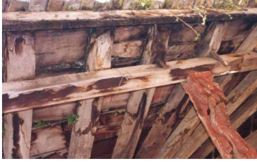
Şekil 192. Çatıda Bitkilenme Ve Çürüme [224]
