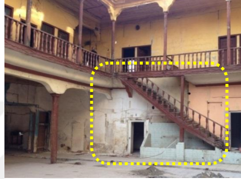
Şekil 491. Ahşap Merdiven [265, 281] Şekil 492. Ahşap Merdiven Bozulma [265, 281]
