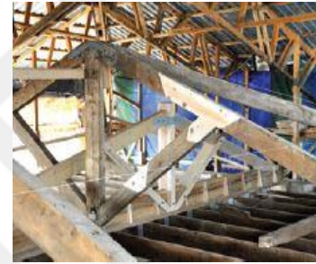
Şekil 257. Ahşap Elemanlarda Güçlendirme [251]
