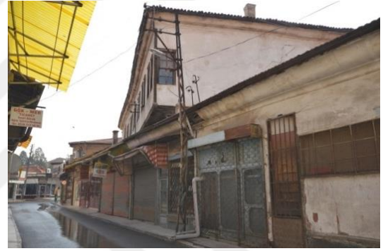
Şekil 471. Veli Paşa Hanı Kuzey Cephesi [265, 281]
