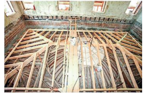
Şekil 252. Mertek Üzeri Ahşap Kirişler [250]
