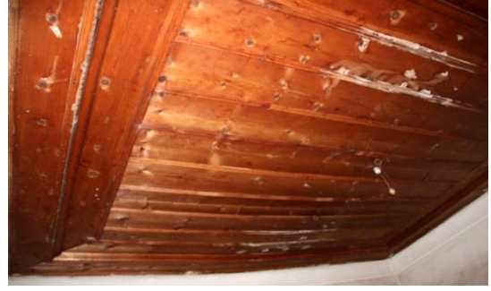
Şekil 354. Çıtalı Ahşap Tavan Kaplaması [265, 271]
