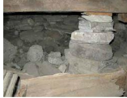
Şekil 226. Yeni Taş Kaideler [239] Şekil 227. 1971'den Kalan Taş Kaideler [239]
