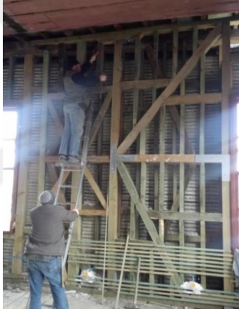
Şekil 531. Taşıyıcı Eleman Birleşimleri [265]
