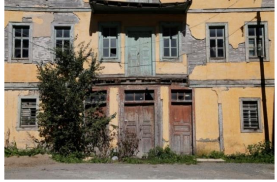
Şekil 135. Bağdadi Sıva Tekniği Kullanılan Bir Ev [171]
