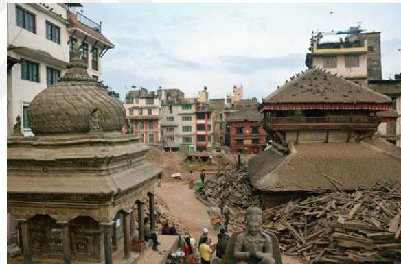
Şekil 185. Deprem Sonrası Kasthamandap Tapınağı [220]
