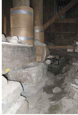
Şekil 226. Yeni Taş Kaideler [239] Şekil 227. 1971'den Kalan Taş Kaideler [239]
