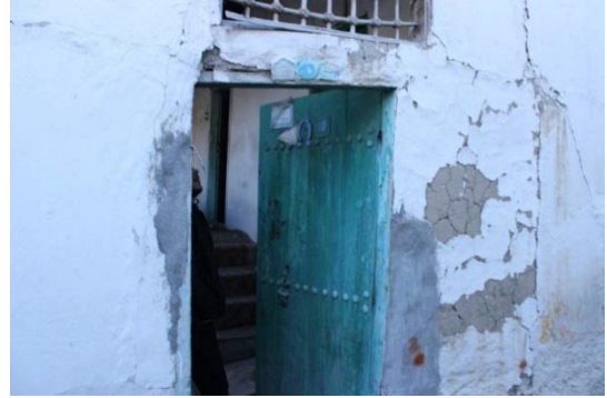
Şekil 389. Kale İçi 2. Ev Duvar [265, 272]
