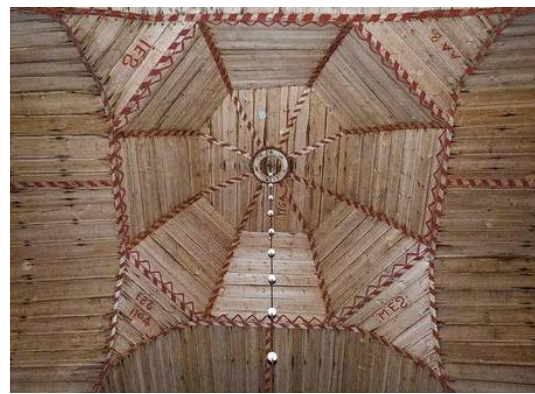
Şekil 60. Petäjävesi Kilise Kubbe [89]
