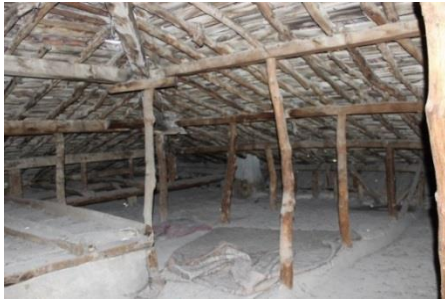
Şekil 414. Ahşap Çatı [265, 272]
