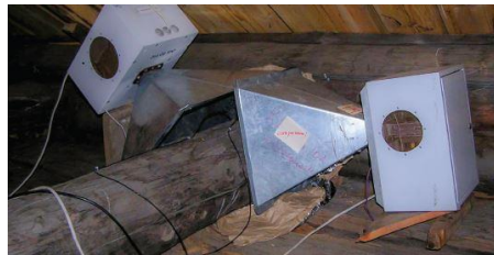
Şekil 211. Zararlı Organizmaların Yerleştiği Ahşapların Onarımı [70]
