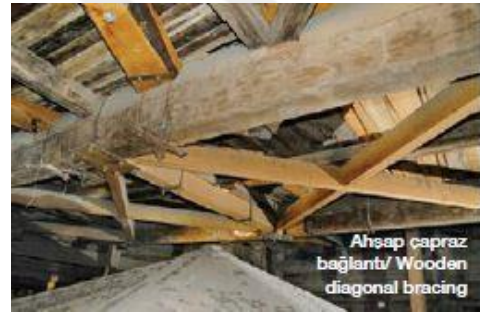
Şekil 202. Kirişler Arası Üçgen Destek [227]
