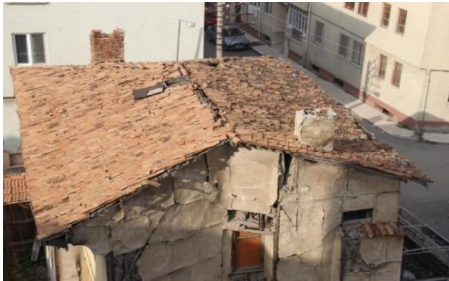
Şekil 355. Ateş Konağı Çatı [265, 271]
