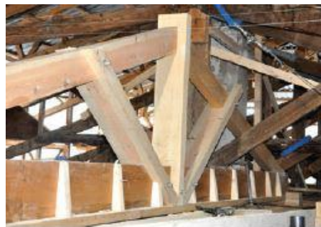
Şekil 258. Çatıya Yerleştirilen Yeni Makas [251]
