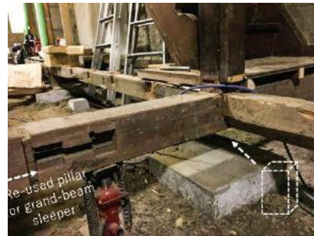
Şekil 209. Döşeme Kirişi Olarak Yeniden Kullanılan Kolon [230]
