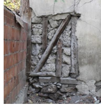
Şekil 331. Taşıyıcı Sistem [265, 271]
