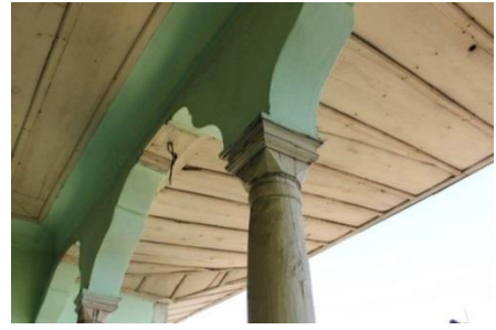
Şekil 415. Ahşap Dikmeler ve Payandalar [265, 272]
