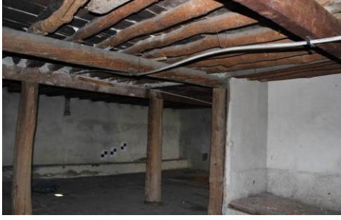
Şekil 410. Zemin Kat Ahşap Kirişler [265, 272]
