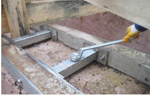
Şekil 271. Çelik Ahşap Birleşimi [252]
