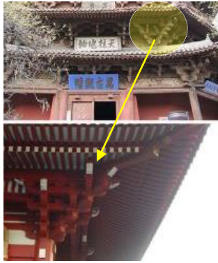
Şekil 199. Dougong destek sistemi [228]
