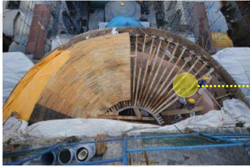
Şekil 277. Ahşap Karkas Sistemin Yeniden Kurulması [254]
