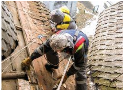
Şekil 218. Geleneksel Yöntemler İle Çatı Sökümü [234]
