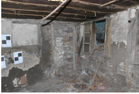
Şekil 371. Z11 Mekâmi Çıtalı Ahşap Tavan Kaplama [265, 272]
