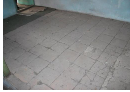
Şekil 333. 30x30 Pişmiş Toprak Döşeme [265, 271]
