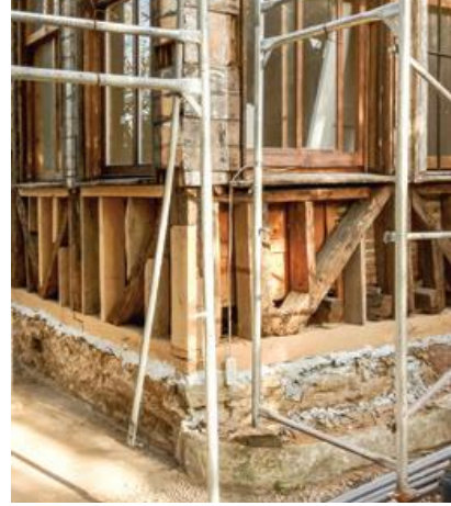
Şekil 248. Ahşap Tabanın Değiştirilmesi [249]
