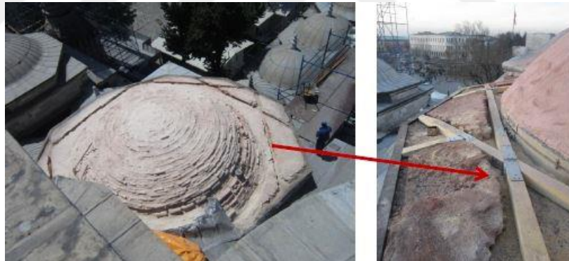
Şekil 273. Kubbede Ahşap Hatıl Boşluğu [254] Şekil 274. Ahşap Hatıl [254]
