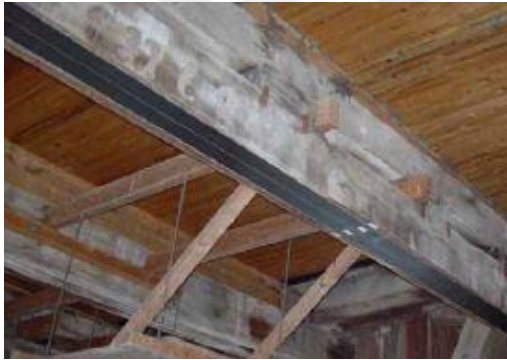
Şekil 188. CFRP İle Güçlendirme [301]
