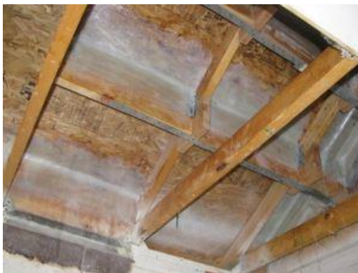
Şekil 190. CFRP İle Güçlendirme [303]
