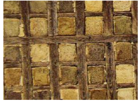
Şekil 131. Göz Dolma Tekniği Uygulaması [159, 174]
