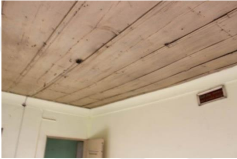
Şekil 412. Çıtalı Ahşap Tavan Kaplama [265, 272]
