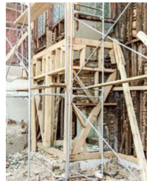
Şekil 246. Ahşap Taşıyıcıların Değiştirilmesi [249]
