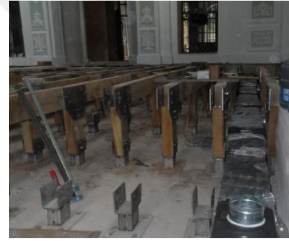
Şekil 270. Yükseltilmiş Döşeme [252]
