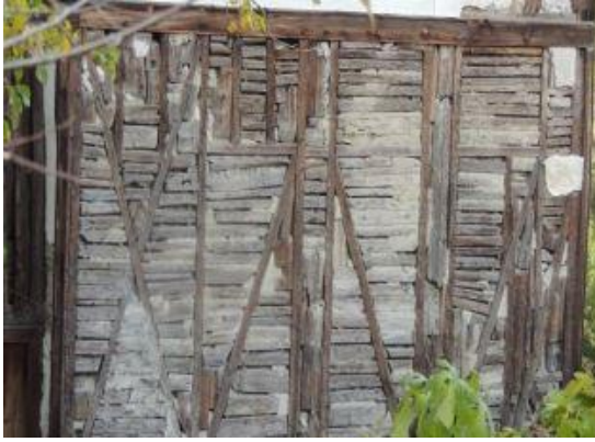
Şekil 138. Ahşap dolgu-Safranbolu [170] Şekil 139. Kerpiç dolgu-Safranbolu [170]
