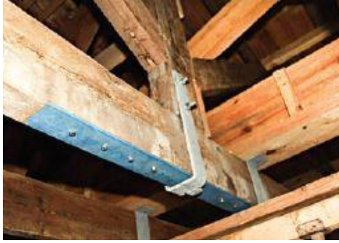
Şekil 259. Makas Ve Kiriş Birleşimi [251] Şekil 260. Yastığa Asılmış Kirişler [251]
