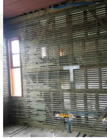
Şekil 532. Taşıyıcı Eleman Birleşimleri [265]
