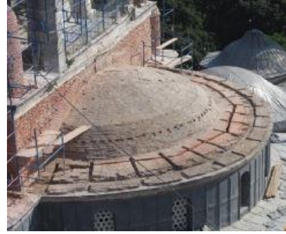
Şekil 276. Ahşap Hatıl Boşlukları [254]
