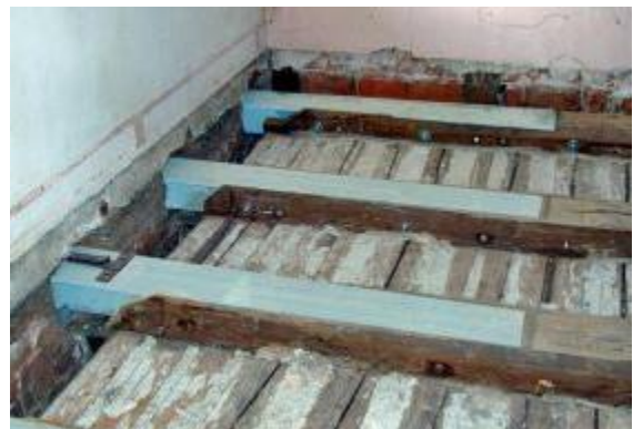
Şekil 191. CFRP İle Güçlendirme [303]
