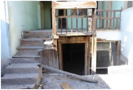
Şekil 418. Ahşap Merdiven ve Korkuluklar [265, 272].
