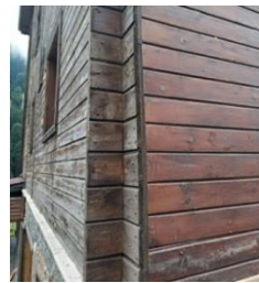
Şekil 122. Köşe Geçme Duvarı-Ayder Yaylası [168]
