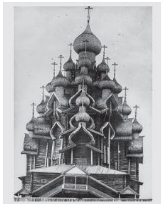
Şekil 214. Kilisenin Restorasyon Öncesi Durumu [234]
