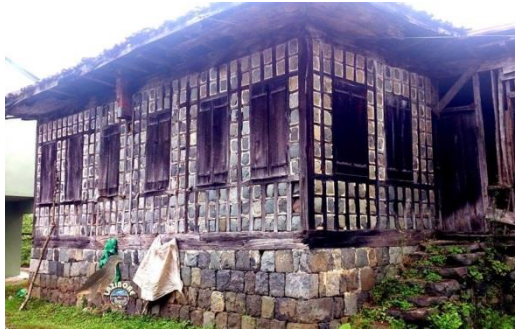
Şekil 130. Göz Dolma Tekniği Uygulaması [173]
