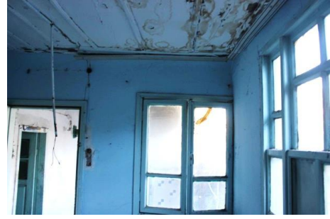
Şekil 393. Çıtalı Ahşap Tavan Kaplaması [265, 272]
