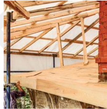
Şekil 250. Ahşap Çatı Onarımı [249]
