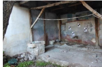
Şekil 395. Depo Ahşap Dikmeler ve Payandalar [265, 272]
