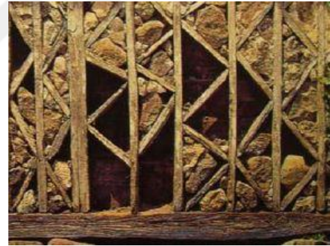
Şekil 133. Muskalı Dolma Tekniği Uygulaması [159, 174]
