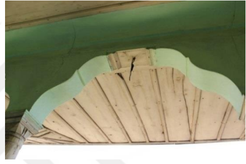
Şekil 413. Çatı Saçağı Kaplaması [265, 272]
