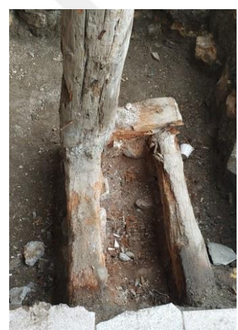
Şekil 512. Çürümüş Hatıl [168]
