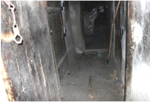
Şekil 369. Zemin Kat Beton Şap [265, 272]
