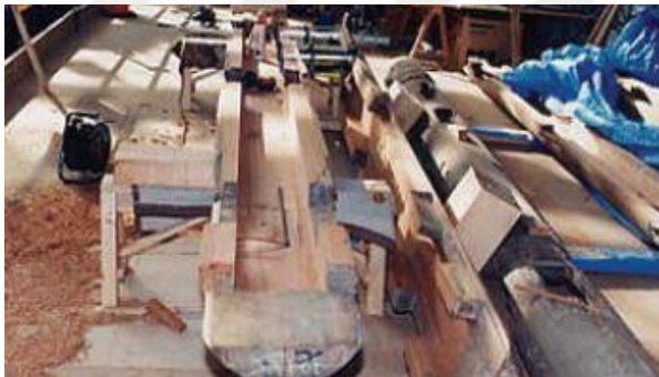
Şekil 186. Hasarlı Kısımın Çıkarılması [223]
