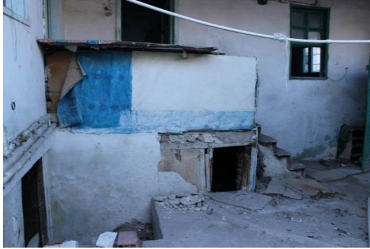
Şekil 388. Duvarda Taşıyıcı Sistem İzleri [265, 272]
