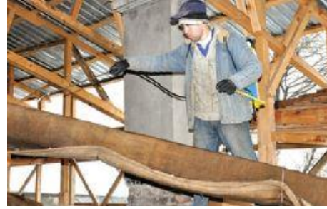
Şekil 262. Aşıkların Islatılması [251]
