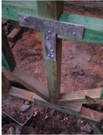
Şekil 533. Taşıyıcı Eleman Birleşimleri [265]
