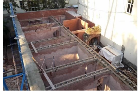
Şekil 272. Çelik Ahşap Kompozit Hatıl Sistemi [252]
