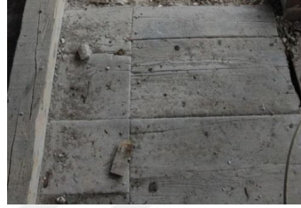
Şekil 520. Döşeme Aşınması [168]
