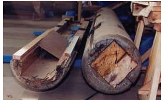
Şekil 187. Yeni Ahşap Elemanın Eklenmesi [223]
