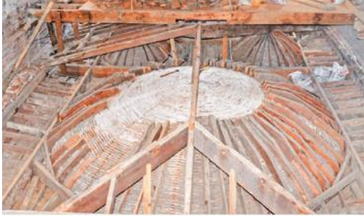
Şekil 251. Ahşap Kubbe [250]
