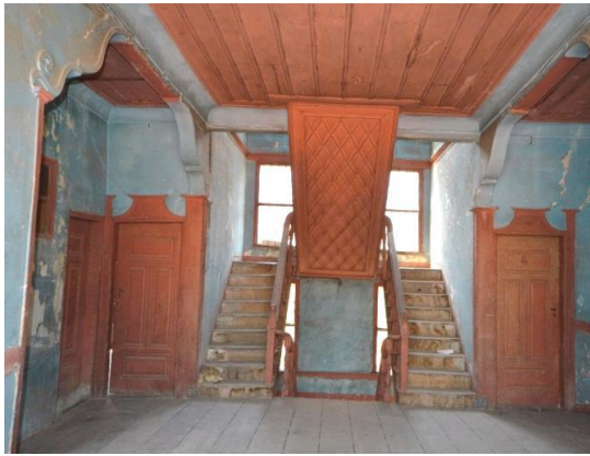
Şekil 459. Anadolu Oteli Merdiven [265, 281]
