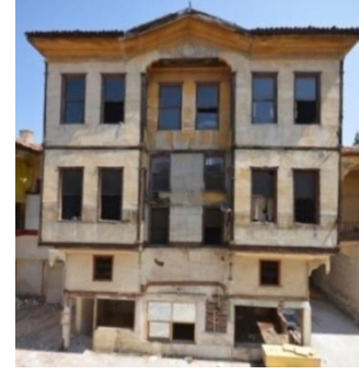
Şekil 456. Köşk Bölümü Batı Cephesi [265, 281]
