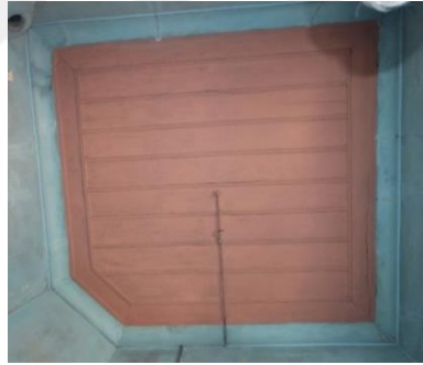
Şekil 488. Çıtalı Ahşap Tavan [265, 281]
