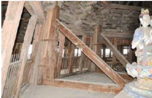
Şekil 201. Dikmelerdeki Üçgen Destek [227]
