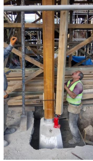
Şekil 536. Güçlendirilmiş Dikmelerin Yerleştirilmesi [265]
