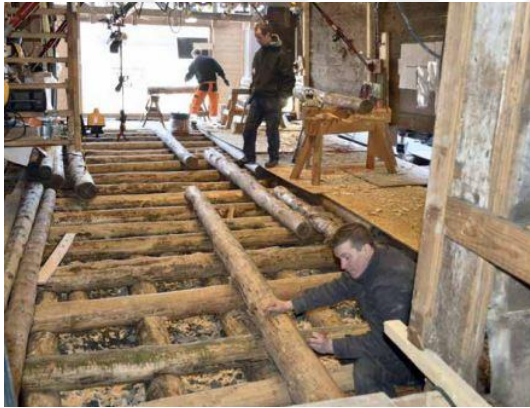
Şekil 223. Temel Restorasyonu Ve Güçlendirme [237]
