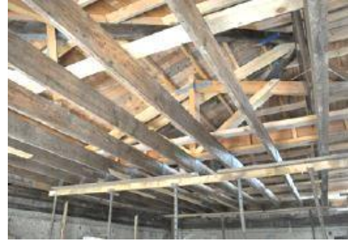
Şekil 259. Makas Ve Kiriş Birleşimi [251] Şekil 260. Yastığa Asılmış Kirişler [251]
