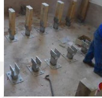
Şekil 268. Yükseltilmiş Döşeme [252]
