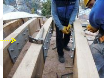
Şekil 278. Ahşap Elemanların Güçlendirilmesi [254]
