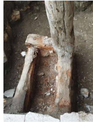
Şekil 481. Ahşap Hatıl [168]
