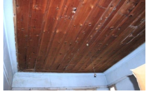
Şekil 315. Ahşap Döşeme [265, 271] Şekil 316. Çıtalı Ahşap Tavan [265, 271]
