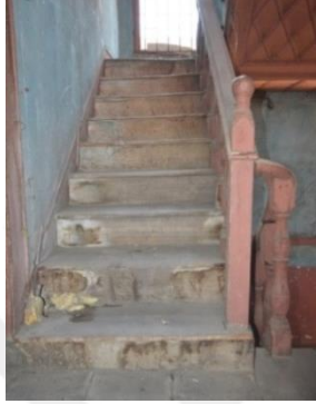
Şekil 491. Ahşap Merdiven [265, 281] Şekil 492. Ahşap Merdiven Bozulma [265, 281]
