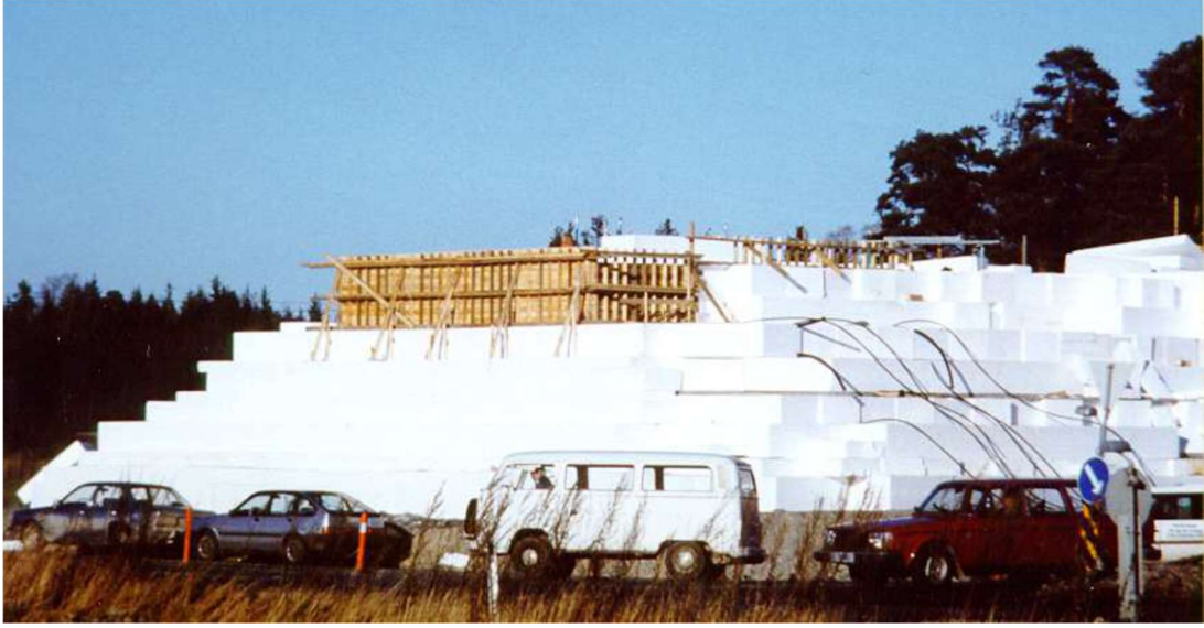
Şekil 1.8 Løkkeberg köprüsünün EPS Geof foam ile inşası (Norveç, 1989)
