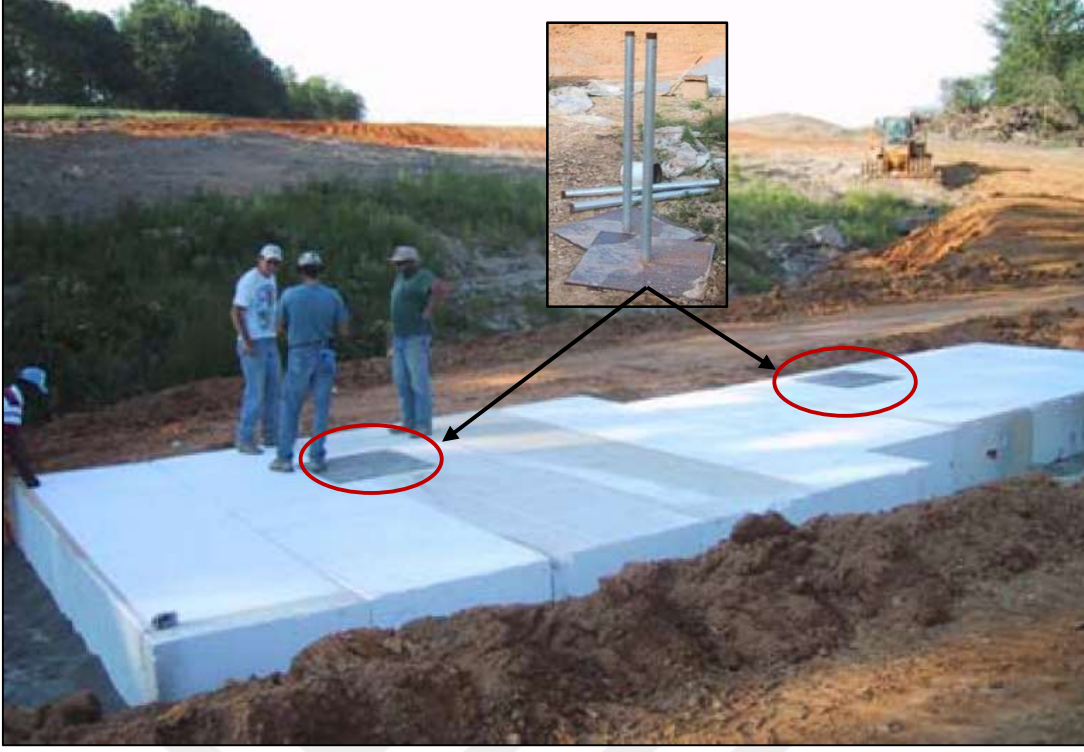
Şekil 1.10 Yerleştirilmiş EPS Geofaom blokları ve oturma plakaları (Sun vd., 2009)
