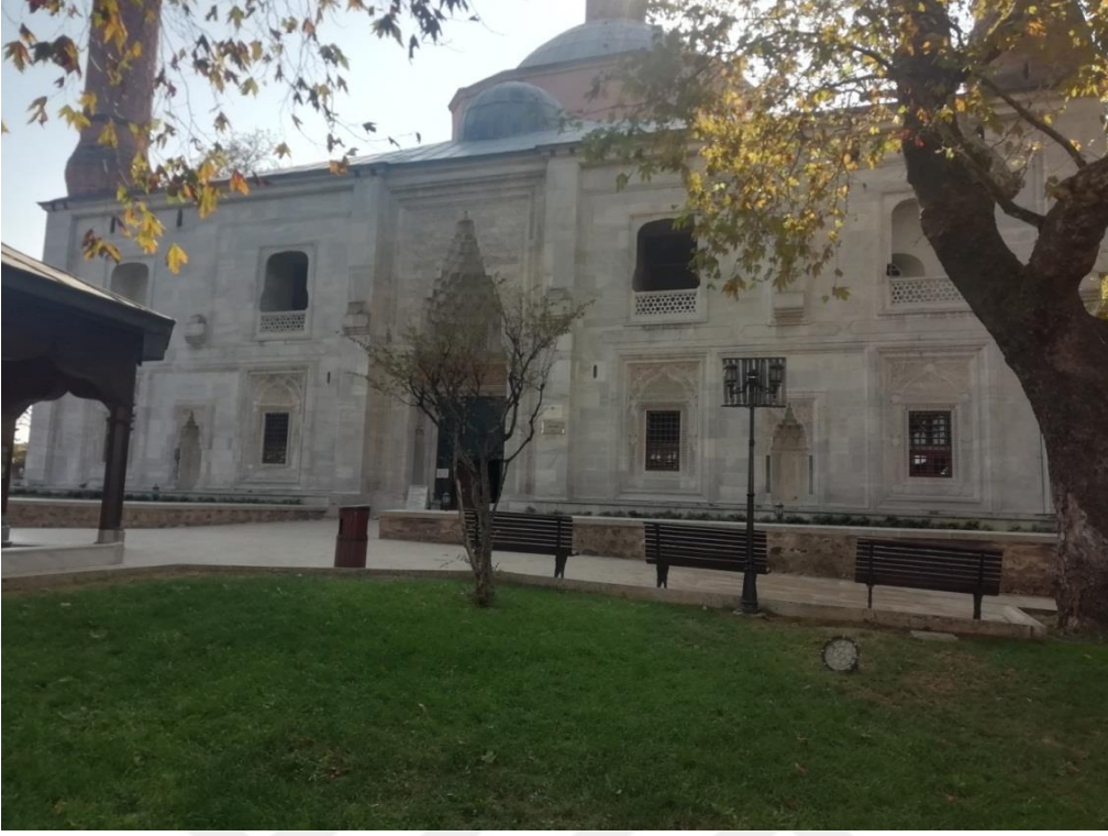
5.Resim. Bursa Yeşil Camii Dış Cephesi Genel Görüntüsü
