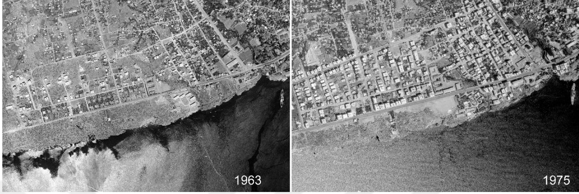
Şekil 3. 4. 1963- 1975 Yılları arasında Konyaaltı Caddesi üzerindeki yapılaşma (Certel 2019)
