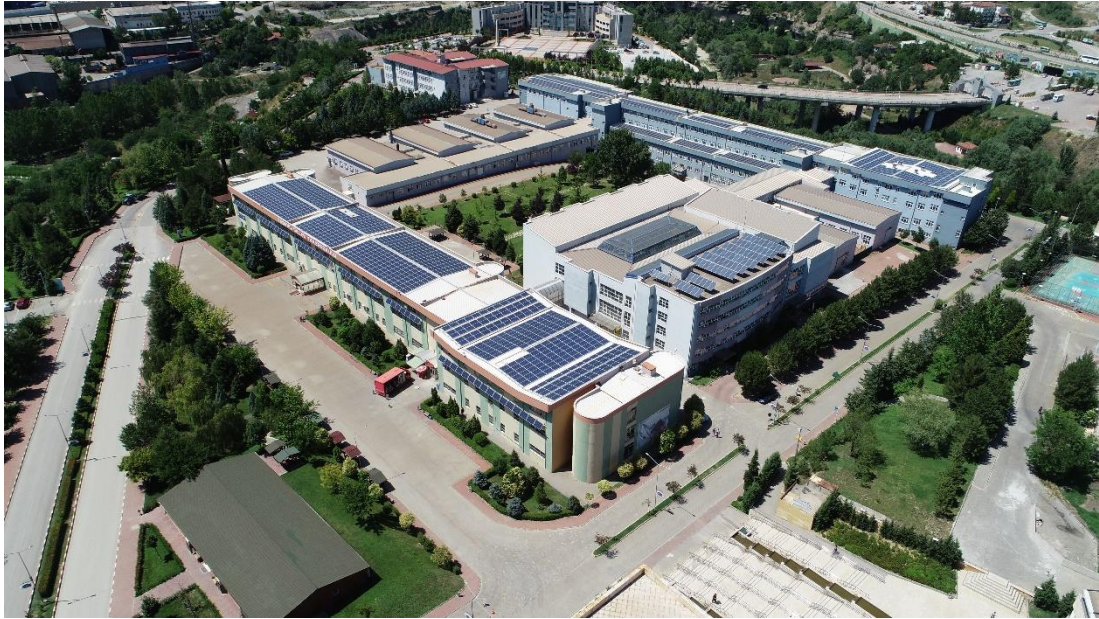
Şekil 4.5. Karabük Üniversitesi güneş panellerinin uzak görünümü [62].
