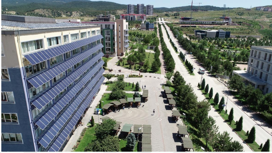
Şekil 4.4. Karabük Üniversitesi güneş panellerinin yakın görünümü [62].
