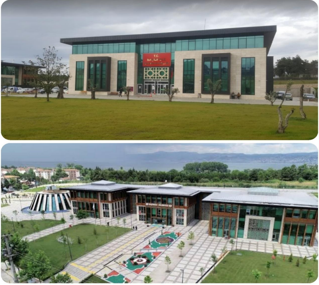
Fotoğraf 2.13. Üste Başiskele Kaymakamlığı Binası, Alttı Başiskele Belediye Binası.
