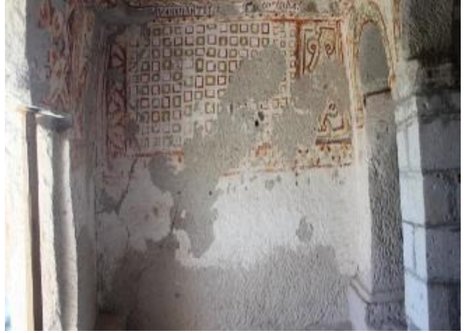
Foto. 26. Naosun batı duvarında pano
