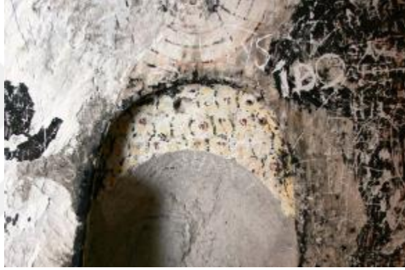
Foto. 37. Apsis duvarı balık pulu
