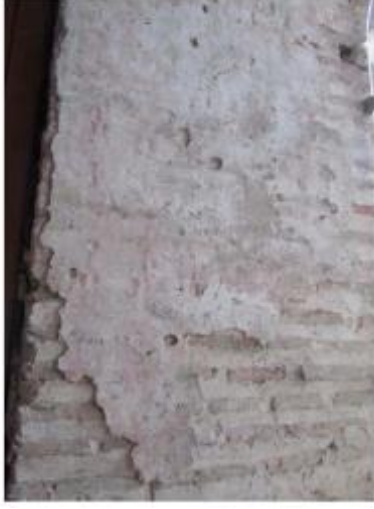
Foto. 220. Kuzey Duvar, Batıdan Birinci Pencere İçi (Sol Kenar) (Ü.Melda Ermiş'den)
