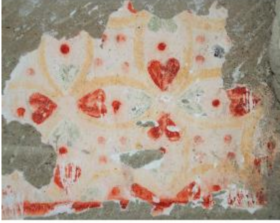
Foto. 149. Güneynef doğu duvarı (Maria Xenaki'den)
