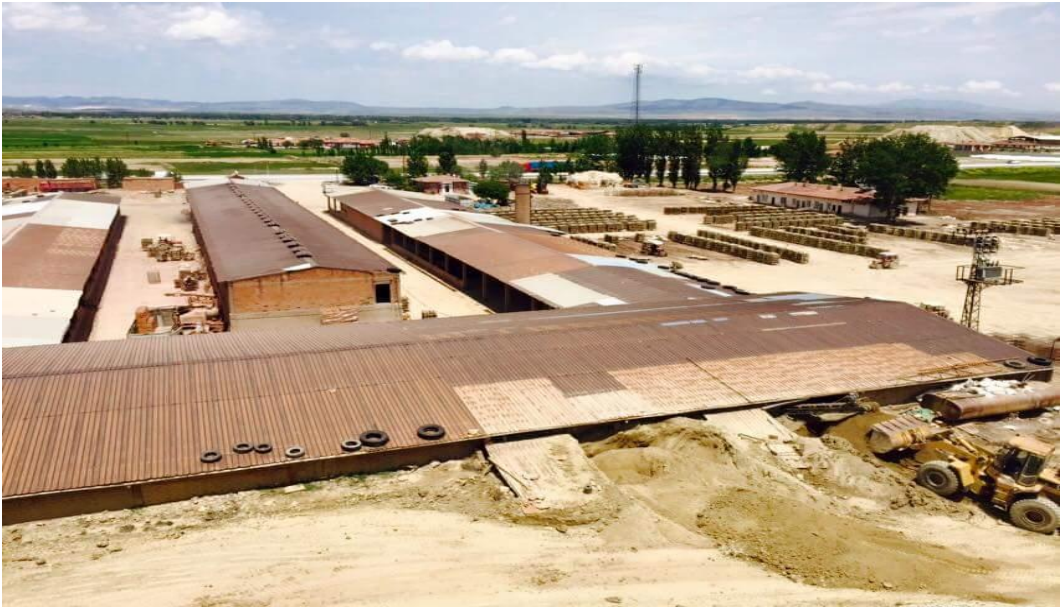
Şekil 6: Tuğla fabrikası görünümü
