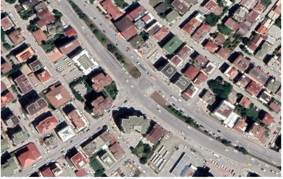
Şekil 4.53. Atakent TV. kavşağı güncel durumu
