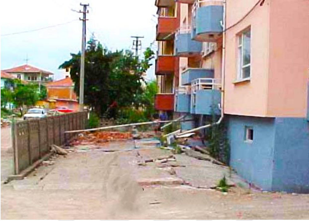
Resim 2.10. Sıvılaşma sonucu meydana gelen oturma (Sancio ve ark., 2004).
