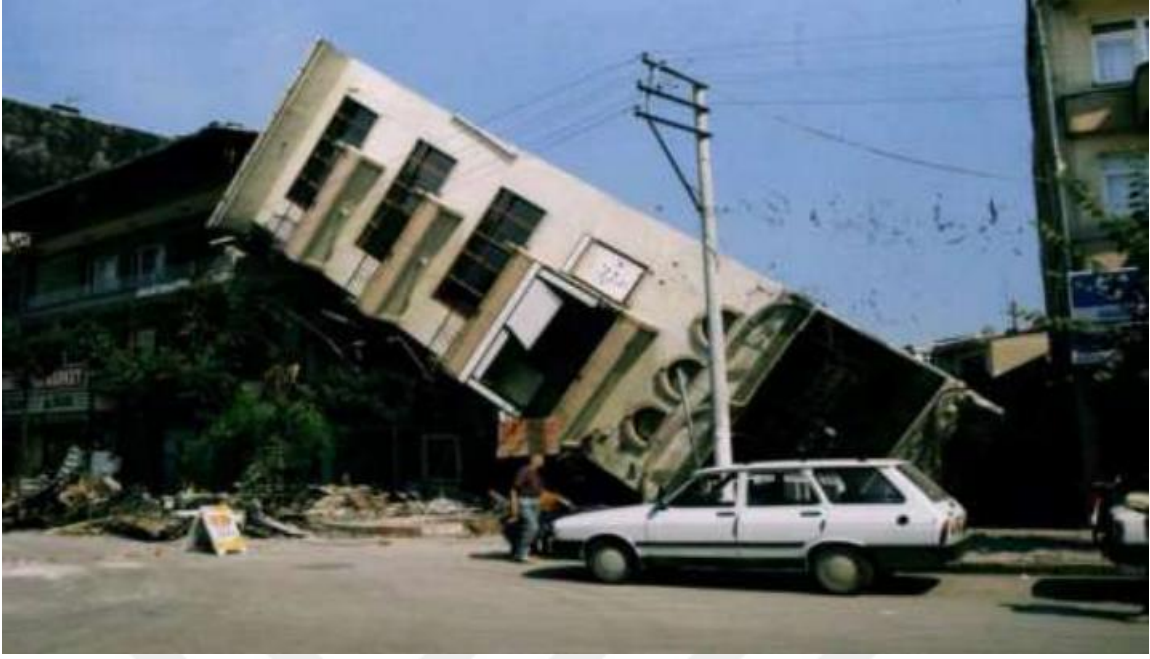
Resim 2.9. Taşıma gücünün yitirilmesi ile devrilen yapı (Çıklaiblikçi, 2019).
