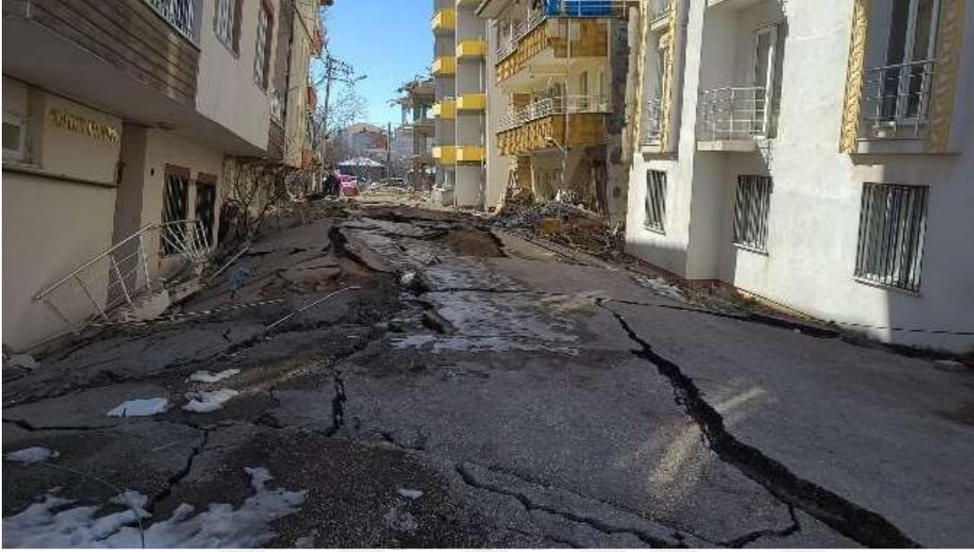
Resim 2.3. Sıvılaşma sonucu taşıma gücü kaybı ve yaşanan kabarma (Yükselen Aksoy ve ark., 2023).
