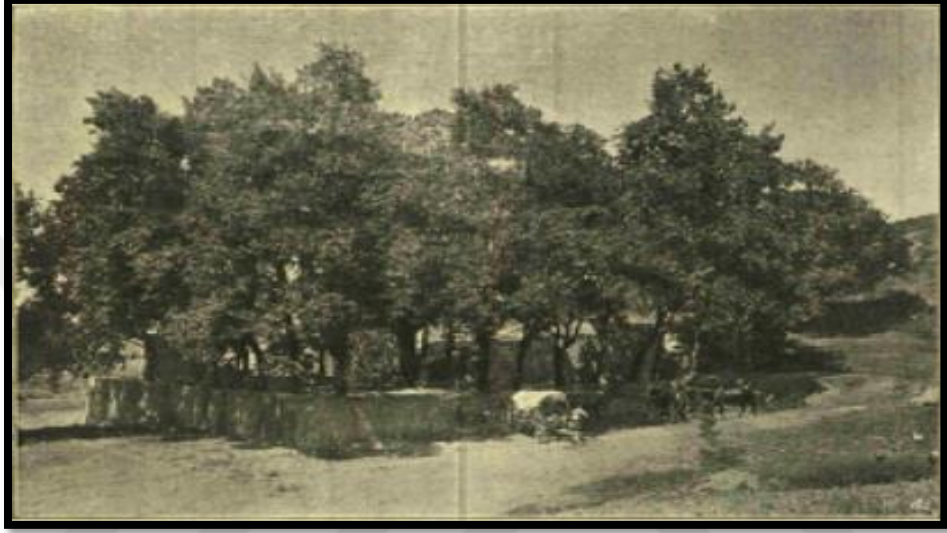
Şekil 4.5. Kayışdağı suyu ana kaynağının 1897'deki görünümü (Url 16,2022)
