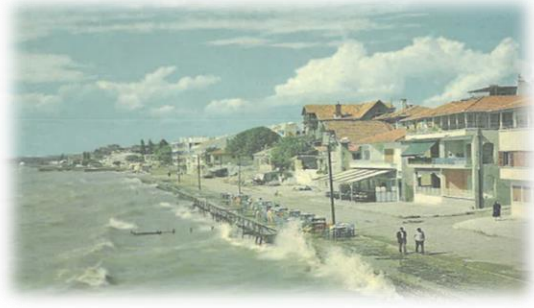
Yalı Mahallesi, Maltepe Sahili 1970 yılı görünüm (Ünker,2013)
