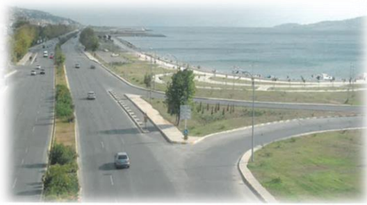
Yalı Mahallesi, Turgut Özal Bulvarı 1990 yılı görünüm (Ünker, 2013)
