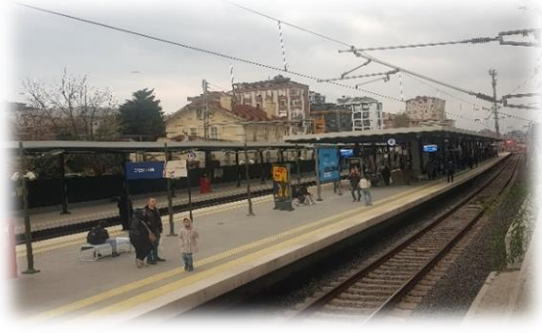
Bağlarbaşı Mahallesi, Maltepe Tren İstasyon
