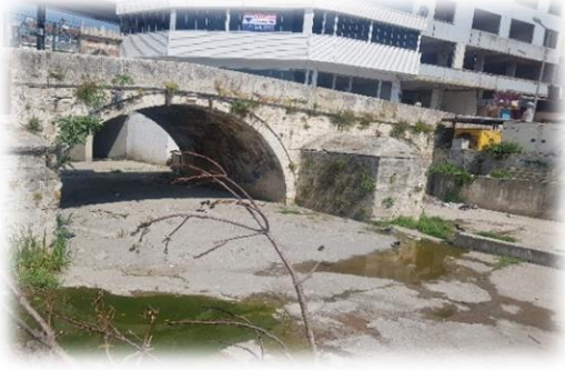
Altıntepe Mahallesi, Bostancıbaşı köprüsü
