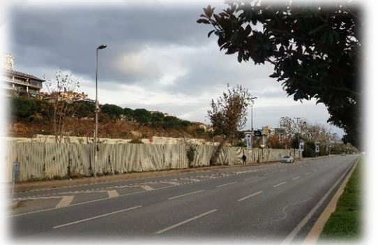
Küçükyalı Mahallesi, Kayahıklar
