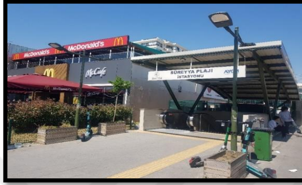
Şekil 4.90. Süreyya Plajı İstasyonu
