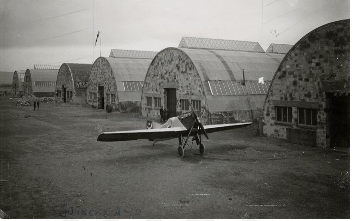
Resim 2.1. TOMTAŞ Fabrikasında Üretilen İlk Junkers A-20 Uçağı, 1927
