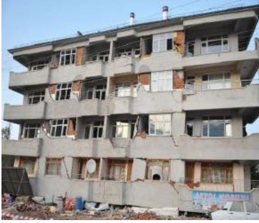
Şekil 3.10 Yumuşak kat oluşumuna bağlı deprem hasarları (Gürer, 2023 ve Yılmaz, 2019)
