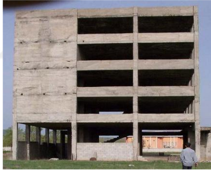
(c) Perdenin alt katta kolona oturması
