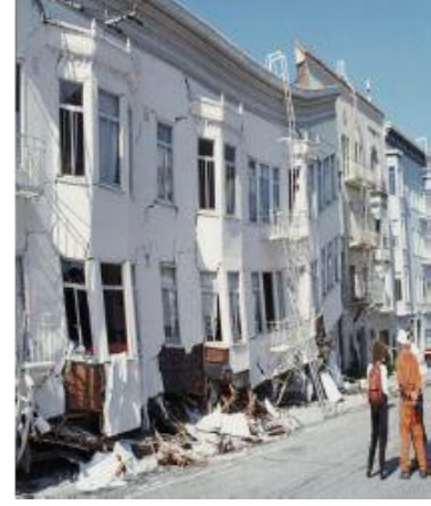
Şekil 3.10 Yumuşak kat oluşumuna bağlı deprem hasarları (Gürer, 2023 ve Yılmaz, 2019)
