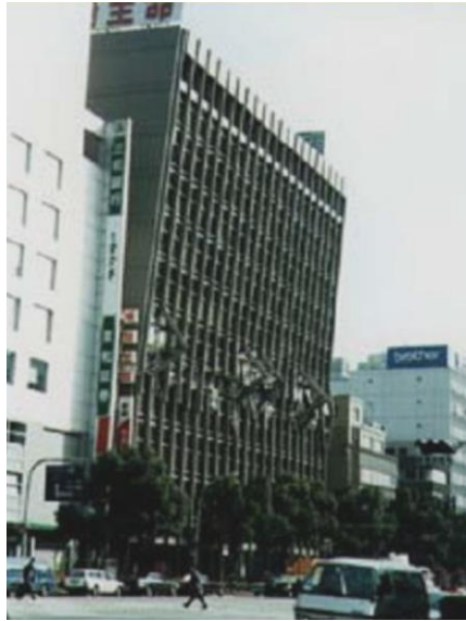
Şekil 3.7 B1 düzensizlik durumunda oluşan deprem hasarı (Sandıkçı, 2014)
