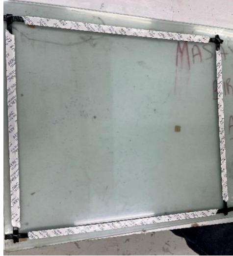
Şekil 3.9. Cam çevresine sızdırmazlık macunu uygulaması
