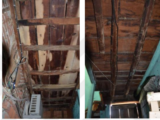
Şekil 3.16: 2704 Ada 15-16 Parsel No.lu Yapının Döşemesi (ATB Mimarlık Arşivi)
