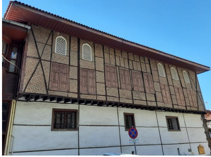
Şekil 3.6: Bursa Muradiye Cami Karşısındaki Tuğla Dolgulu Ev (Anonim, 2023)
