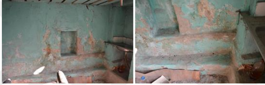
Şekil 3.10: 2704 Ada 15-16 Parsel Nolu Yapının Z03-1 Mekanından Temel Çıkıntısı (ATB Mimarlık Arşivi)
