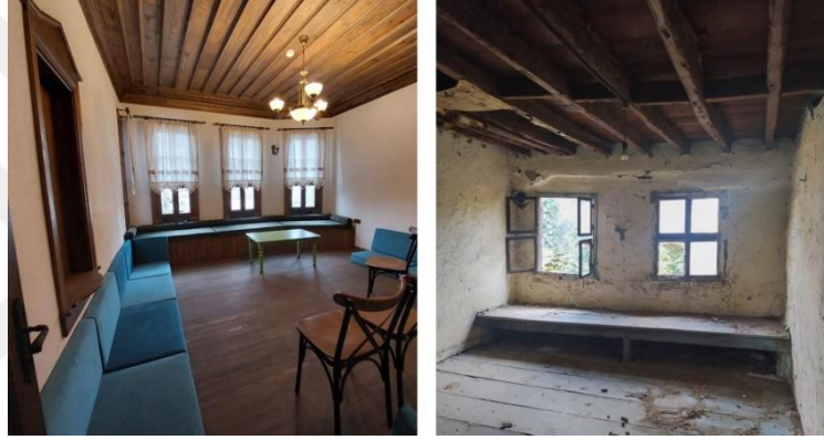
Şekil 2.32: 2704 15-16 Parsel No.lu Yapıdaki Oda (Sol) (Karabulut 2022 Arşivi), 2697 Ada 18 Parsel No.lu Yapıdaki Oda (Sağ) (Stoa Mimarlık Arşivi)
