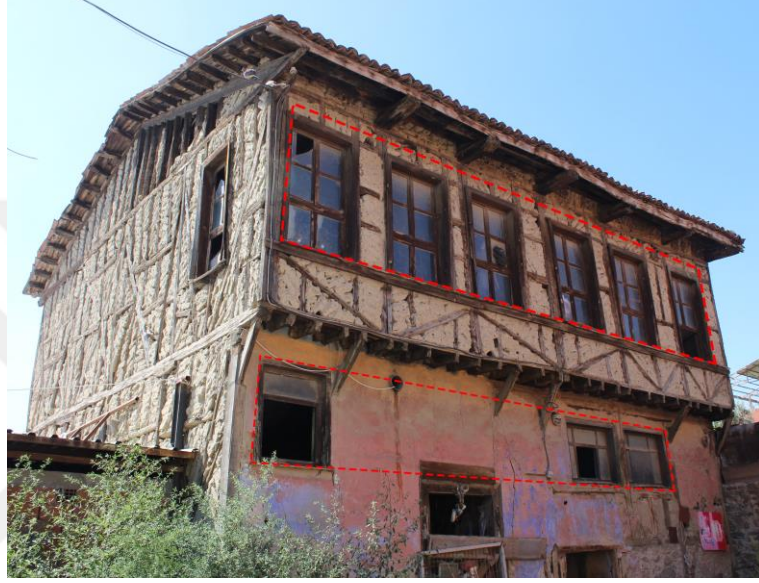
Şekil 3.25: 2705 Ada 43 Parseldeki Konutun Ara Kat ve Esas Kat Pencereleleri
