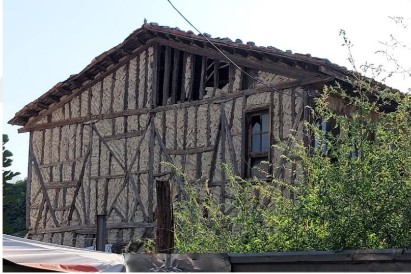
Şekil 3.9: Ahşap Çatki Arası Kerpiç Dolgulu Duvar Örneği
