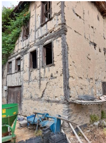
Şekil 3.4: 2697 Ada 18 Parsel No.lu Yapının Kerpiç Dolgulu ve Kerpiç Sıvalı Dış Duvarı
