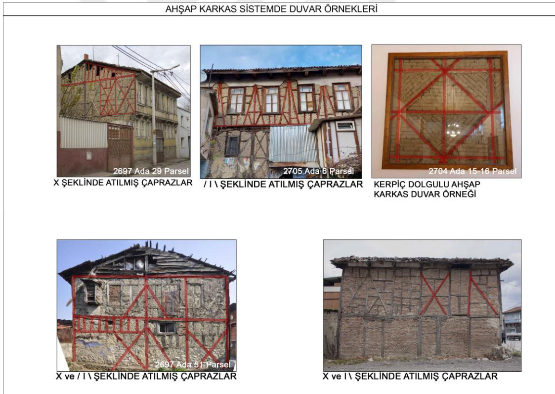
Şekil 3.14: İsabey Mahallesi'nden Ahşap Karkas Sisteminde Duvar Örnekleri (Karabulut 2023)
