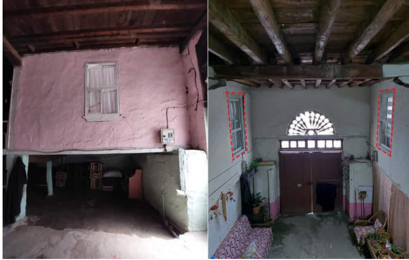
Şekil 3.27: Taşlık Mekanına Bakan Pencereler (sol: 2697 Ada 29 Parsel, sağ: 2705 Ada 6 Parsel) (Karabulut, 2023)
