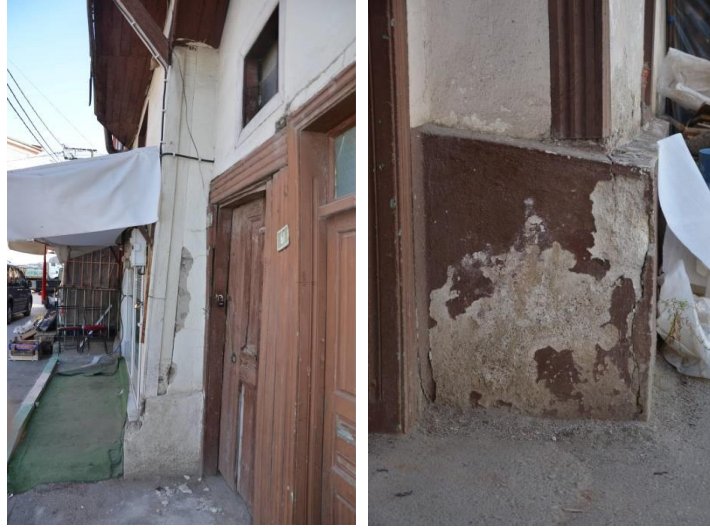
Şekil 3.11: 2704 Ada 15-16 Parsel No.lu Yapının Kuzey Cephesinden Temel Görüntüsü
