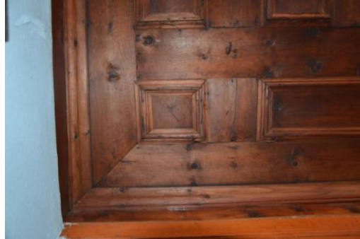
Şekil 2.33: 2704 Ada 15-16 Parsel Ahşap Pasalı Tavan Kaplaması (ATB Mimarlık Arşivi)
