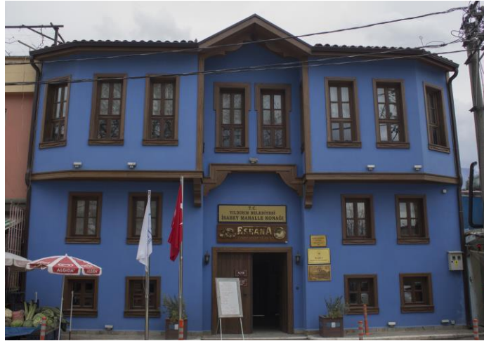
Şekil 2.31: 2704 Ada 15-16 Parsel No.lu Yapının Sokak Cephesi (Karabulut 2022)
