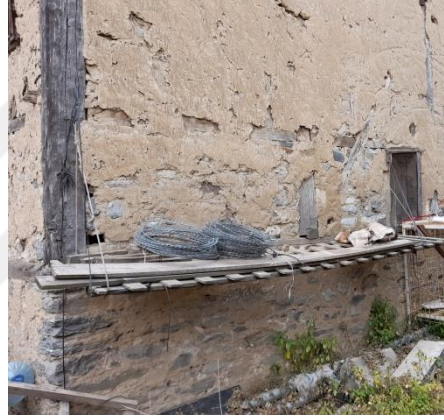
Şekil 3.5: Moloz Taş Yığma Duvar Örneği (2697 Ada 18 Parseldeki Yapı)
