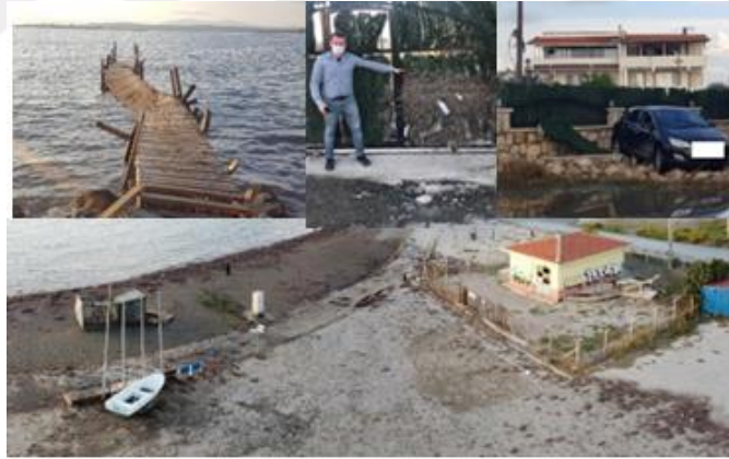
Şekil 6.26 Tsunami etkisiyle meydana gelen hasarlar (İnt. Kyn. 15).
