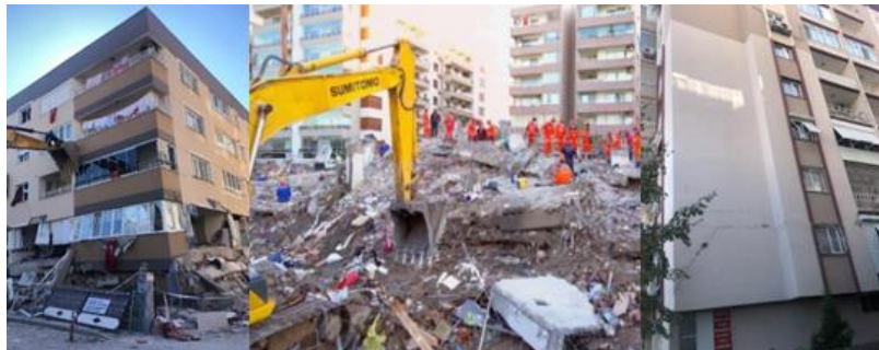
Şekil 6.27 Depremin neden olduğu yıkım ve yapılardaki hasarı (İnt. Kyn. 15, İnt. Kyn. 17).
