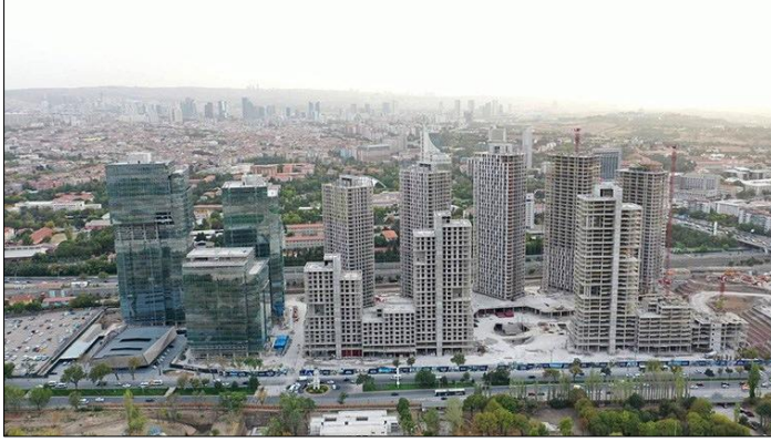
Resim 2.2. Merkez Ankara konutlarından bir görünüm ( https://www.emlakkonut.com.tr/ )
