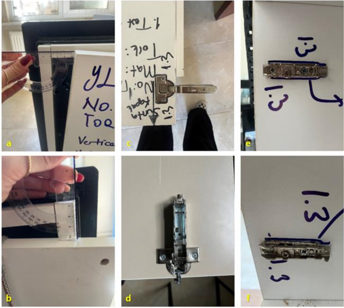
Şekil 5.3: 1,3 N/m torkta montajlanmış kapakların son durumu; (a). Kapak menteşe deformasyonu, (b). Kapak deformasyonu, (c). Alt menteşe, (d). Üst menteşe, (e). Alt menteşe bağlantı elemanı, (f). Üst menteşe bağlantı elemanı.
