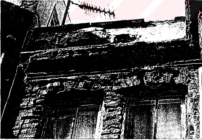
Fotoğraf 3-5. Cephe bozulmaları
