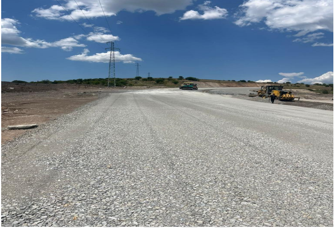
Şekil 1.9 Korgun-Kurşunlu arası yolunda alt temel tabakası
