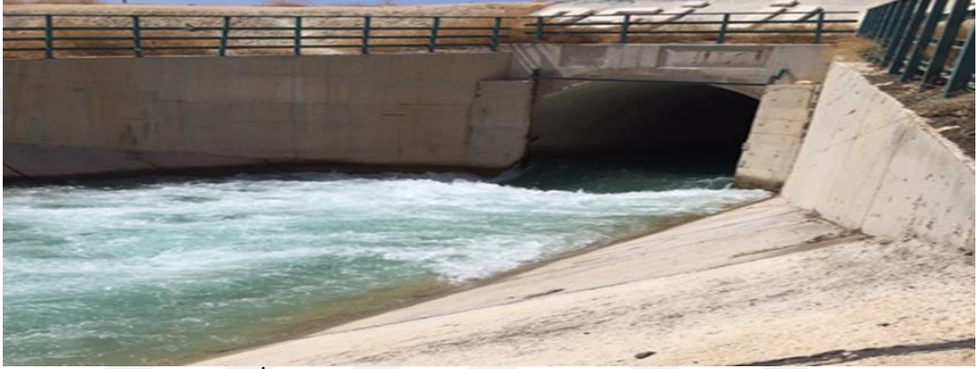
Şekil 3.4. Tünel girişi (DSİ, 2017)
