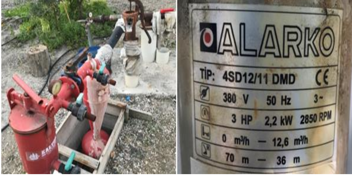
Resim 3.2. Filtrasyon ünitesi ve pompa özellikleri
