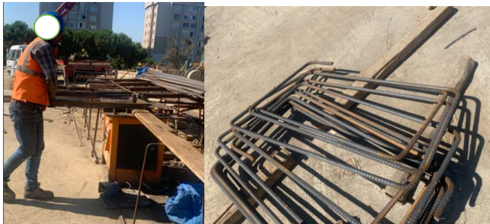
Şekil 23. Diyafram perde etriyemeri bükülmesi
