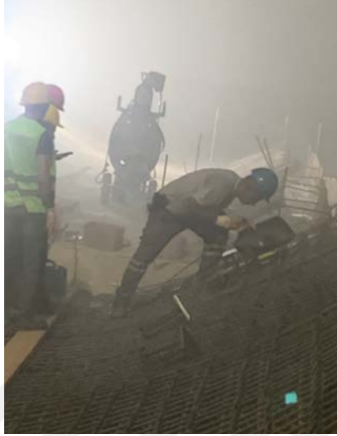
Şekil 18. Dış taraftan kaynak yapımı
