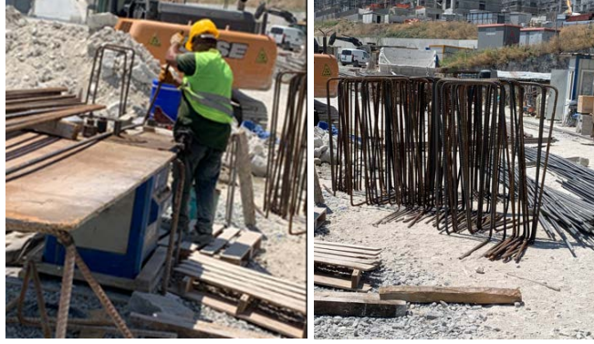
Şekil 24. Temel sehbası demiri bükülmesi
