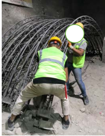
Şekil 26. Montaj yapılması için iksa taşınması
