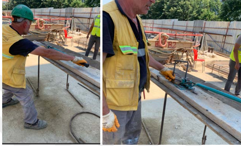
řekil 22. 16 mm aplı demirin bükölmesi
