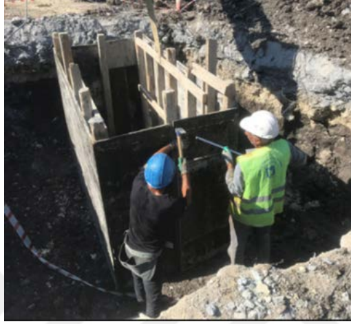
Şekil 12. Dış kalıp çakılması
