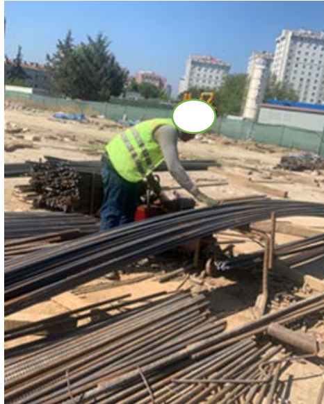
Şekil 15. Uzun demirlerin kesilmesi
