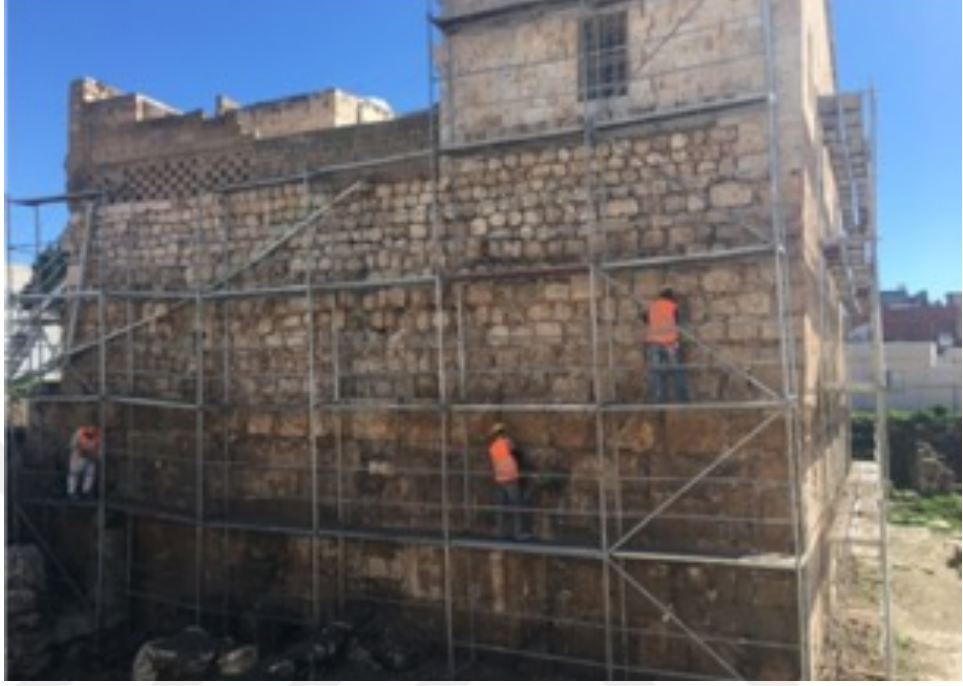
Görsel 6: Kuzey cephesinde yapılan restorasyon çalışması, 2019 (Mardin Müzesi Arşivi).
