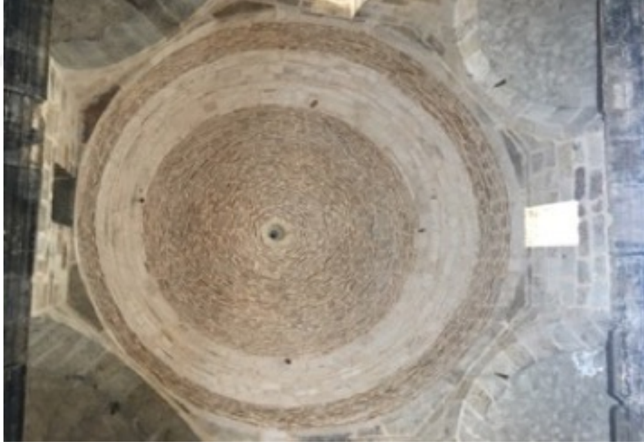
Görsel 9: Kubbe restorasyon çalışması sonrası, 2019, (Mardin Müzesi Arşivi).
