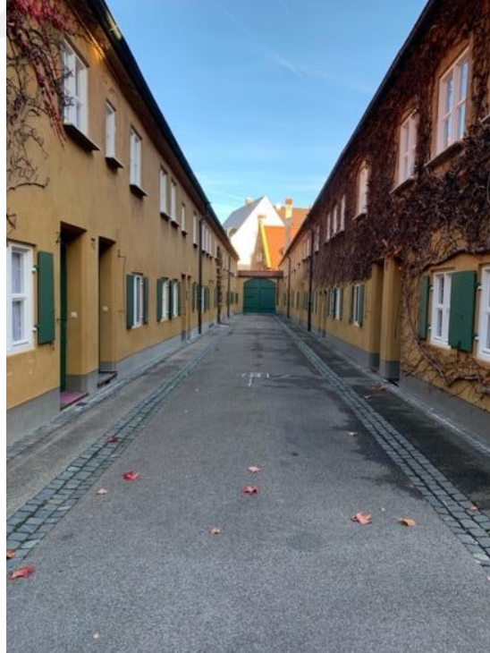
Şekil 3.12 Fuggerei , sokağa bakış (Şaşmaz Özdöl, 2021)
