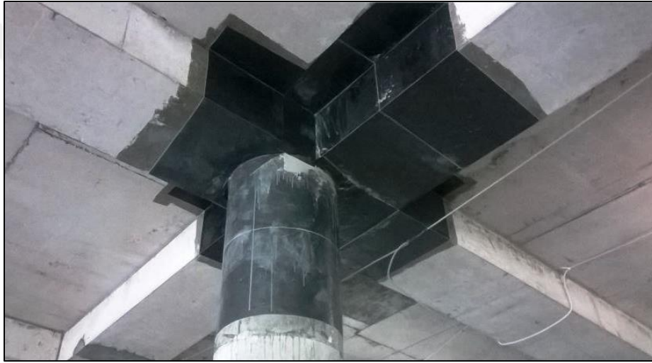
Şekil 3.10 Karbon elyaf ile taşıyıcı eleman güçlendirmesi
