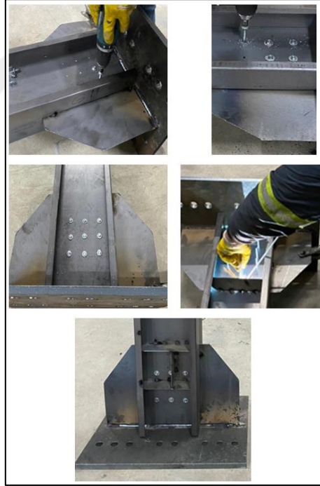
Şekil 4.1. Çelik Yapının Montajının Görselleri
