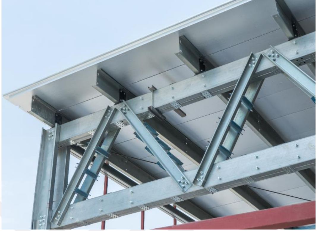
Şekil 1.5. Hafif Çelik Çatı Birleşimleri
