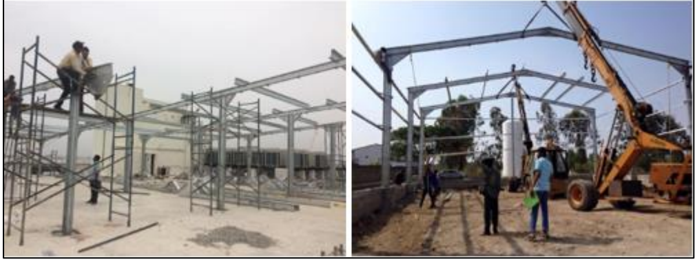
Şekil 1.1. Hafif Çelik Yapı Yapımı
