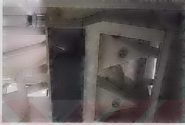
Şekil 21. Denizli Organize Sanayi Bölgesi'nde Bulunan Karakurt Gıda Fabrikası'nda Baca Gazı Denetiminde Kullanılan Siklon
