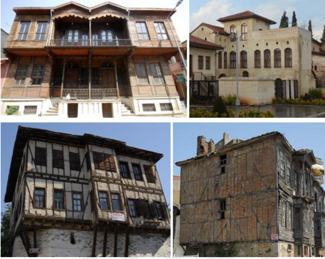
Fotoğraf 2.10. Geleneksel konutta ahşap, taş, kerpiç ve tuğla kullanımı (Cambaz Arşivi)
